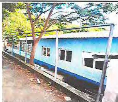
Foto 3: Sustitución de muro perimetral de malla galvanizada de 1.80 mts de alto, tubo galvanizado y block
