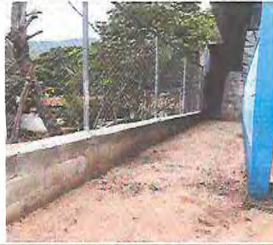
Foto 8: Construcción de banqueta y muro perimetral de malla y block
