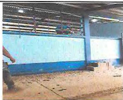
Foto 17: Sustitución de estructura de soporte de metal y vidrio por ventanas corredizas con material de PVC
