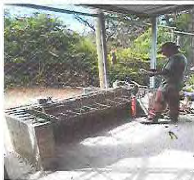
Foto 13: Instalación de lavamanos de concreto con 3 llaves de chorro
