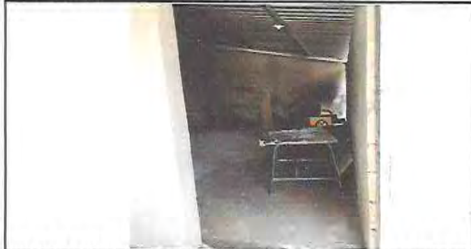
Foto 19: Mantenimiento a bodega (Sustitución de puerta de madera por puerta de metal)
