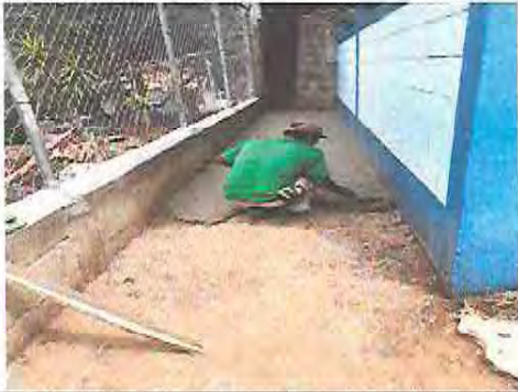
Foto 7: Construcción de banqueta y muro perimetral de malla y block
