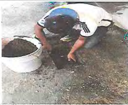
Foto 9: Sustitución de cuneta de concreto con caja de registro
