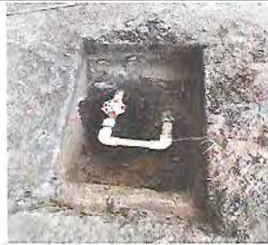
Foto 10: Sustitución de cuneta de concreto con caja de registro
