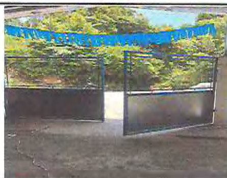
Foto 6: Mantenimiento a portón de metal
