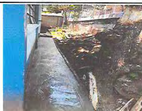
Foto 16: Construcción de banqueta y muro perimetral de malla y block
