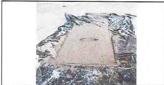
Foto 23: Sustitución de cuneta de concreto con caja de registro
