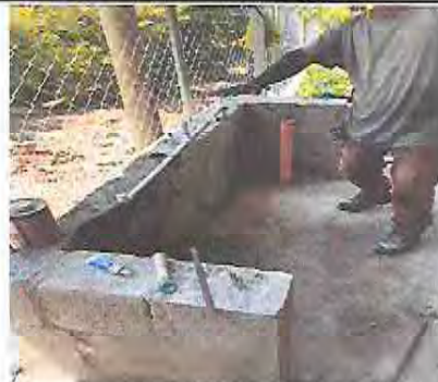
Foto 14: Instalación de lavamanos de concreto con 3 llaves de chorro
