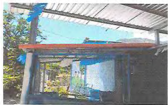
Foto 22: Instalación de canal bajante de agua pluvial de material de PVC
