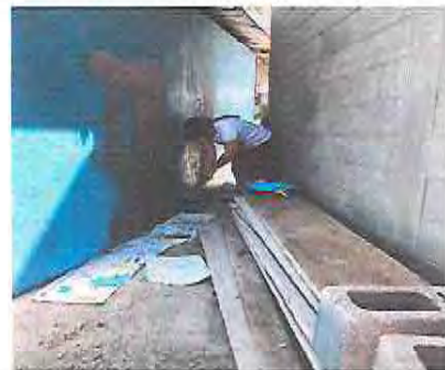
Foto 12: Pintura en muros interiores y exteriores
