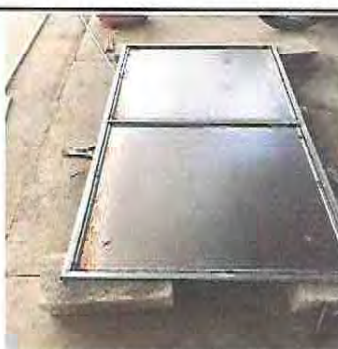
Foto 18: Mantenimiento a bodega (Sustitución de puerta de madera por puerta de metal)
