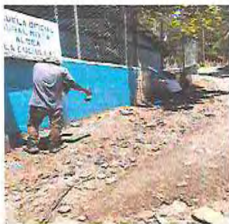
Foto 11: Pintura en muros interiores y exteriores
