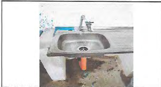
Foto 21: Sustitución de llave de chorro
