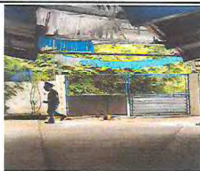
Foto 5: Mantenimiento a portón de metal
