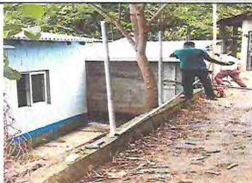
Foto 1: Sustitución de muro perimetral de malla galvanizada de 1.80 mts de alto, tubo galvanizado y block
