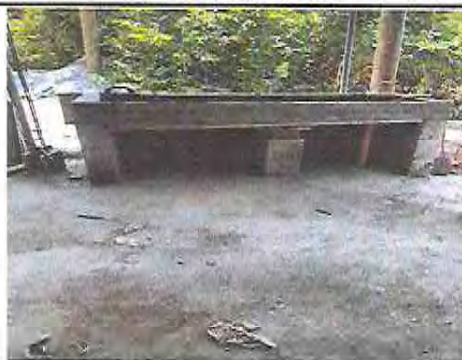
Foto 15: Instalación de lavamanos de concreto con 3 llaves de chorro
