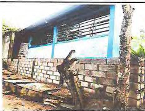
Foto 4: Sustitución de muro perimetral de malla galvanizada de 1.80 mts de alto, tubo galvanizado y block
