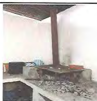
Foto 18: Sustitución de estufa rural completa (Incluye polletón, chimenea y plancha de metal)
