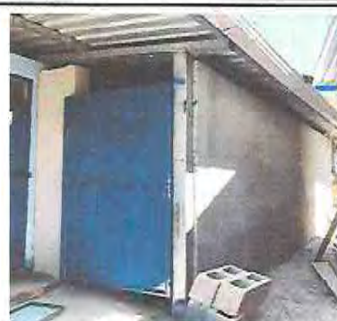
Foto 20: Mantenimiento a bodega (Sustitución de puerta de madera por puerta de metal)
