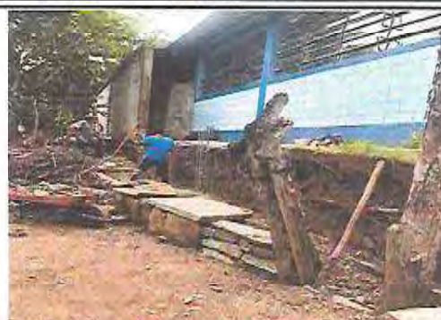
Foto 2: Sustitución de muro perimetral de malla galvanizada de 1.80 mts de alto, tubo galvanizado y block
