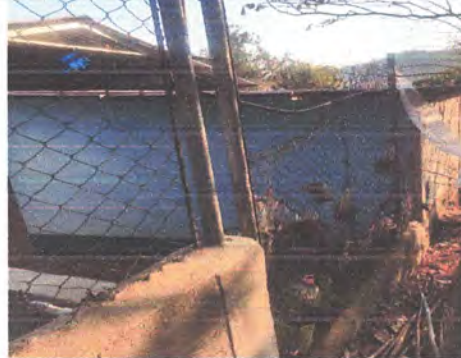
MANTENIMIENTO A ESTRUCTURA DE METAL DEL MURO PERIMETRAL
