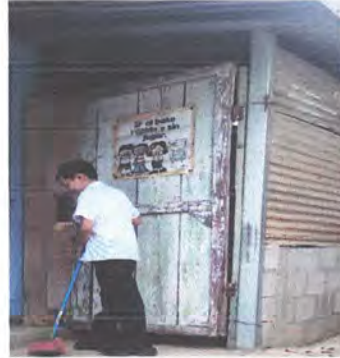
Foto2: Mantenimiento a bodega (Sustitución de puerta de madera por metal, repello y cernido en paredes y sustitución de canal plástico por canal de metal)
