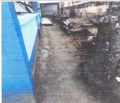
REPARACIÓN DE CUNETETA DE CONCRETO (BANQUETA)
