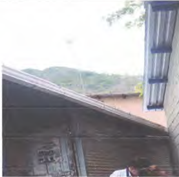
Foto3: Mantenimiento a bodega (Sustitución de puerta de madera por metal, repello y cernido en paredes y sustitución de canal plástico por canal de metal)
