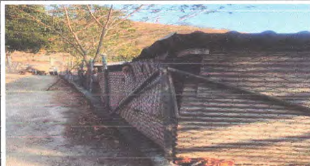
Mantenimiento a bodega
