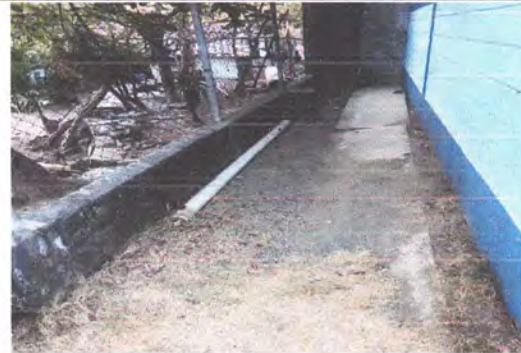
REPARACIÓN DE CUNETETA DE CONCRETO (BANQUETA)
