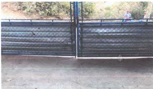
Mantenimiento a porton de metal
