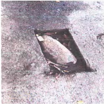
SUSTITUCIÓN DE CUNETETA DE CONCRETO CON CAJA DE REGISTRO
