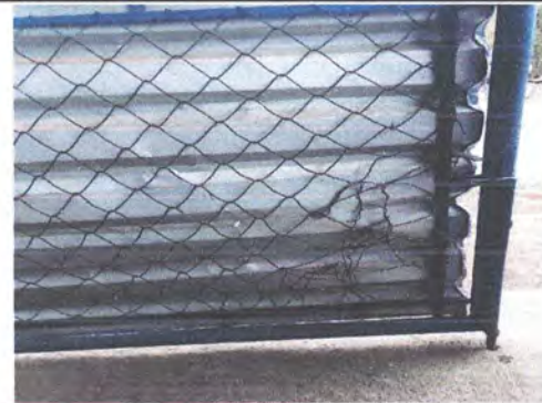
MANTENIMIENTO A PORTONES DE METAL
