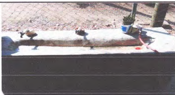
Sustitucion de llave de chorro
