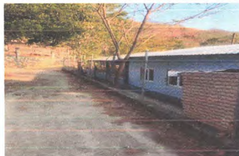
Reparacion de muro perimetral de block
