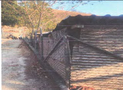
MANTENIMIENTO A ESTRUCTURA DEL MURO PERIMETRAL
