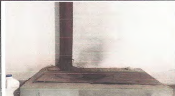
Sustitución de estufa rural ( completa) incluye chimenea y palcha de metal
