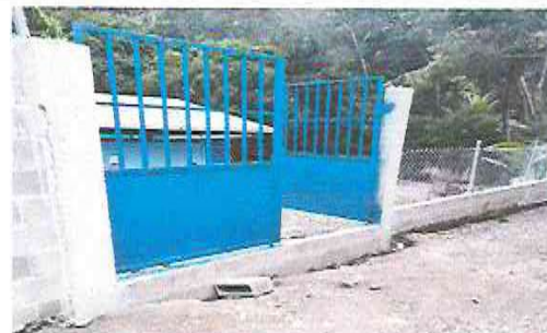
Foto 6: Sustrucción de portón de metal de 2.10 mts de largo por 2.50 mts de alto
