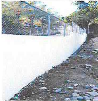
Foto 7: Sustrución de muro perimetral de block y malla (incluye hierro, cemento, arena, alambre de amarre y malla galvanizada)
