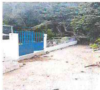
Foto 11: Sustrución de muro perimetral de block y malla (incluye hierro, cemento, arena, alambre de amarre y malla galvanizada)
