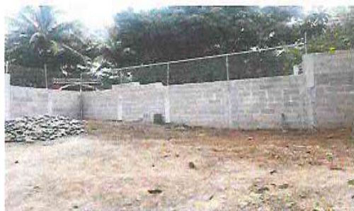
Foto 1: Sustrucción de muro perimetral de block y malla (incluye hierro, cemento, arena, alambre de amarre y malla galvanizada)
