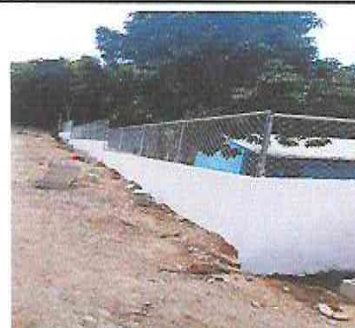
Foto 10: Sustrución de muro perimetral de block y malla (incluye hierro, cemento, arena, alambre de amarre y malla galvanizada)
