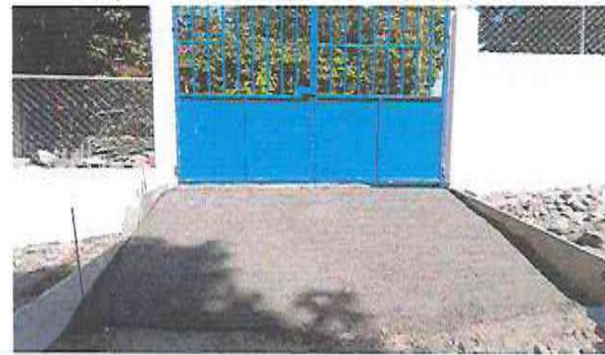
Foto 8: Suministro e instalación de rampa entrada principal
