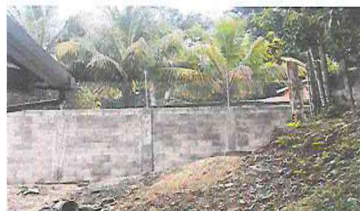
Foto 4: Sustrucción de muro perimetral de block y malla (incluye hierro, cemento, arena, alambre de amarre y malla galvanizada)
