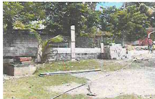
Foto 2: Sustrucción de muro perimetral de block y malla (incluye hierro, cemento, arena, alambre de amarre y malla galvanizada)
