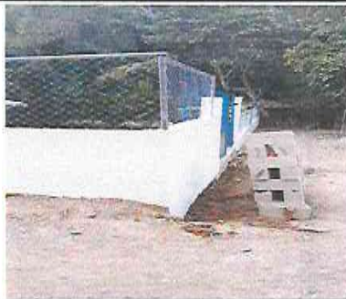
Foto 9: Sustrución de muro perimetral de block y malla (incluye hierro, cemento, arena, alambre de amarre y malla galvanizada)
