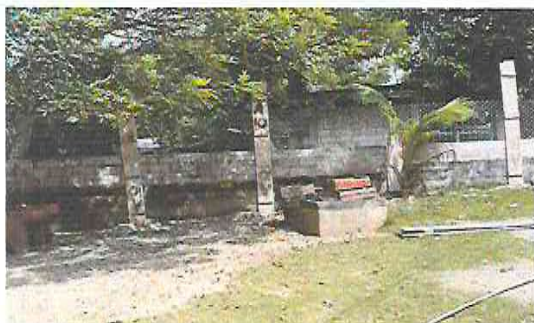
Foto 3: Sustrucción de muro perimetral de block y malla (incluye hierro, cemento, arena, alambre de amarre y malla galvanizada)
