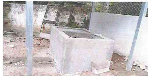
Foto 12: Suministro e instalación de pila de concreto
