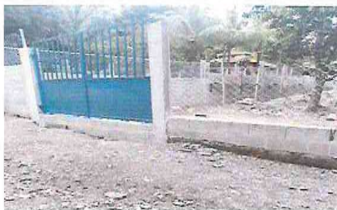
Foto 5: Sustrucción de portón de metal de 2.10 mts de largo por 2.50 mts de alto
