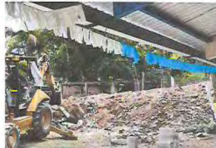
Foto 12: Sustrucción de muro perimetral de block y malla (incluye hierro, cemento, arena, alambre de amarre y malla galvanizada)
