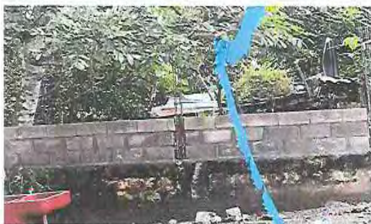
Foto 18: Sustrucción de muro perimetral de block y malla (incluye hierro, cemento, arena, alambre de amarre y malla galvanizada)
