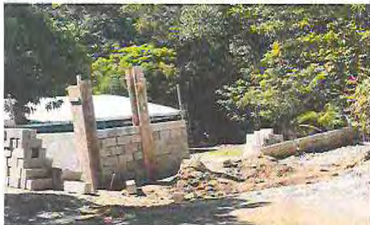
Foto 16: Sustrucción de muro perimetral de block y malla (incluye hierro, cemento, arena, alambre de amarre y malla galvanizada)
