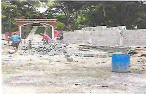
Foto 1: Sustitución de muro perimetral de block y malla (incluye hierro, cemento, arena, alambre de amarre y malla galvanizada)
