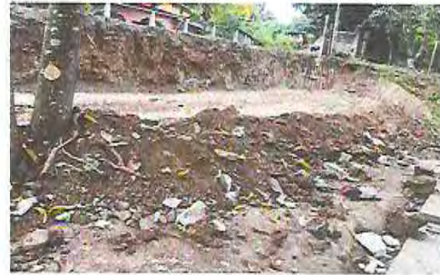
Foto 10: Sustrucción de muro perimetral de block y malla (incluye hierro, cemento, arena, alambre de amarre y malla galvanizada)
