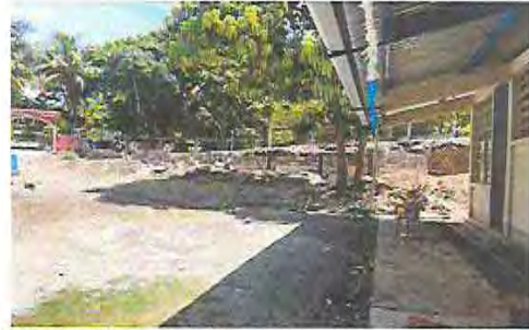
Foto 8: Sustrucción de muro perimetral de block y malla (incluye hierro, cemento, arena, alambre de amarre y malla galvanizada)
