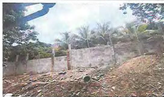
Foto 19: Sustrucción de muro perimetral de block y malla (incluye hierro, cemento, arena, alambre de amarre y malla galvanizada)
