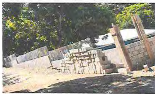
Foto 17: Sustrucción de muro perimetral de block y malla (incluye hierro, cemento, arena, alambre de amarre y malla galvanizada)
