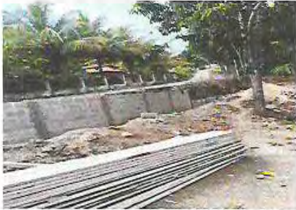
Foto 7: Sustrucción de muro perimetral de block y malla (incluye hierro, cemento, arena, alambre de amarre y malla galvanizada)
