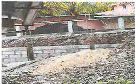
Foto 5: Sustitución de muro perimetral de block y malla (incluye hierro, cemento, arena, alambre de amarre y malla galvanizada)
