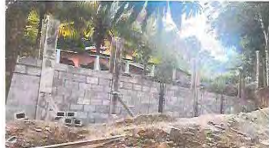
Foto 6: Sustitución de muro perimetral de block y malla (incluye hierro, cemento, arena, alambre de amarre y malla galvanizada)
