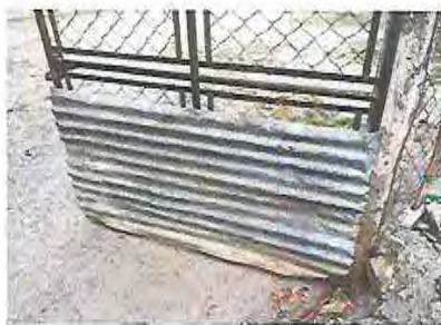
Foto 15: Sustitución de portón de metal de 2.10 mts de largo por 2.50 mts de alto
