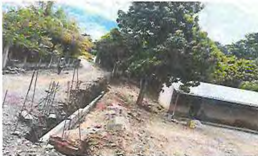
Foto 9: Sustrucción de muro perimetral de block y malla (incluye hierro, cemento, arena, alambre de amarre y malla galvanizada)
