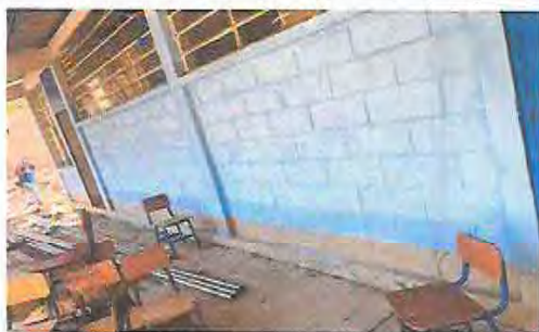
Foto 20: Pintura en muros interiores y exteriores en el módulo de aulas
