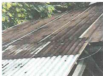
foto 11: Susutitucion de lamina troquelada
