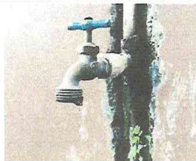
Foto 8: sustitucion de tubería
