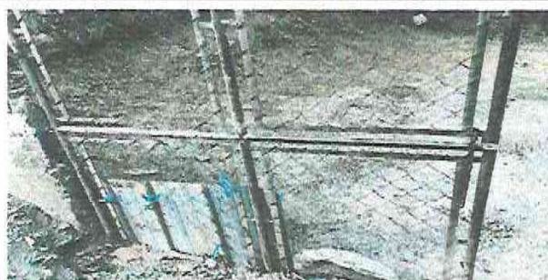
foto 5: sustitucion de porton de metal
