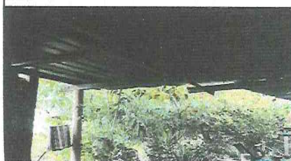
Foto 10: sustitucion de soporte madera por metal
