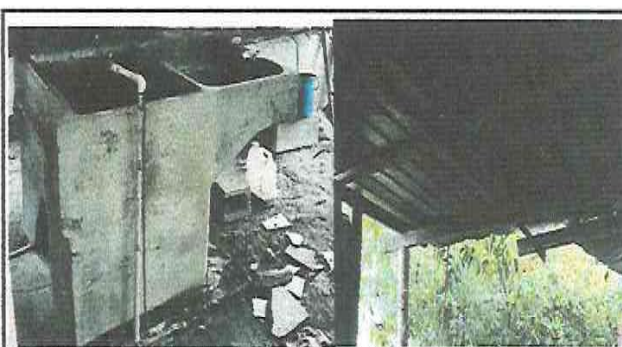
Foto 4: colocacion de pila prefabricada y estructura de techo
