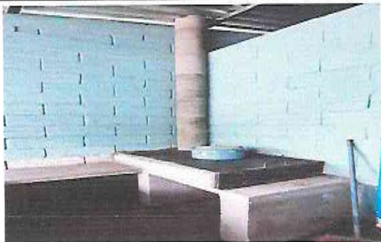
Foto1: construcción e instalación de estufa rural
