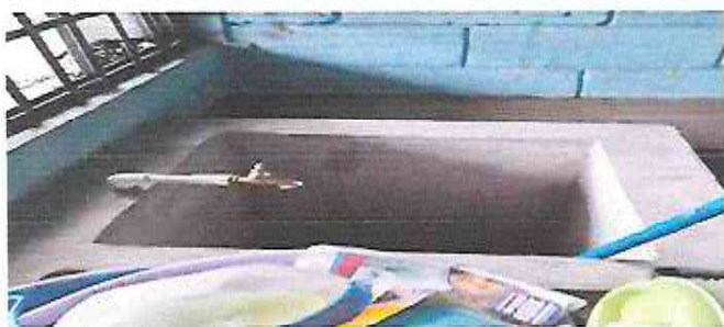
FOTO 5: Construcción de pila
