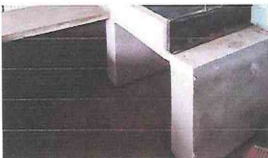
FOTO 3: cambio de piso encementado a cerámico
