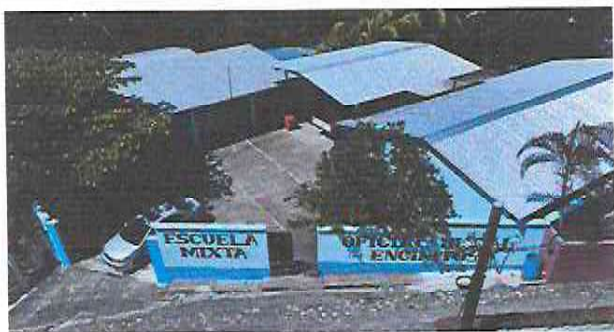
Foto 1: Sustrucción de lámina por lámina troquelada calibre 26"
