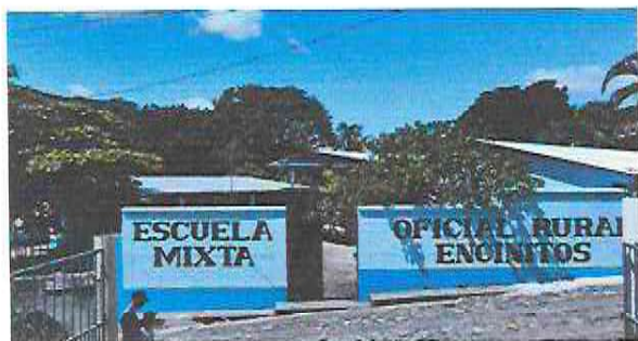
Foto 3: Pintura Interior y exterior
