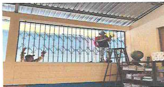
Foto 4: Sustrucción de ventanas por balcones
