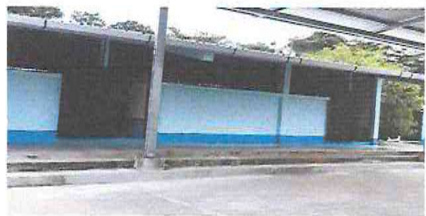
Foto 6: Mantenimiento y pintura a puertas de metal
