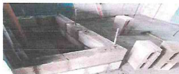
FOTO 4: Construcción de pila
