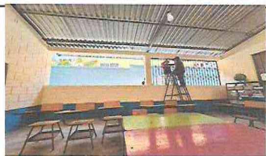
Foto 4: Sustitución de ventanas por balcones
