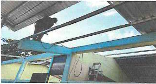
Foto1: Sustitución de lámina por lámina troquelada calibre 26"
