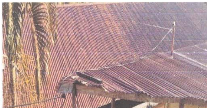
Sustitución de lámina por lámina troquelada aluzinc calibre 26 en el modulo de las aulas
