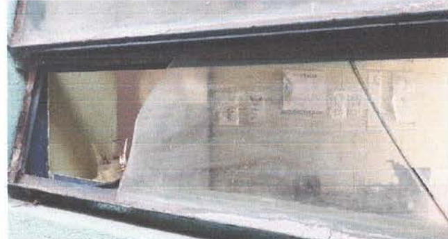
Mantenimiento a estructura de metal de ventanas
