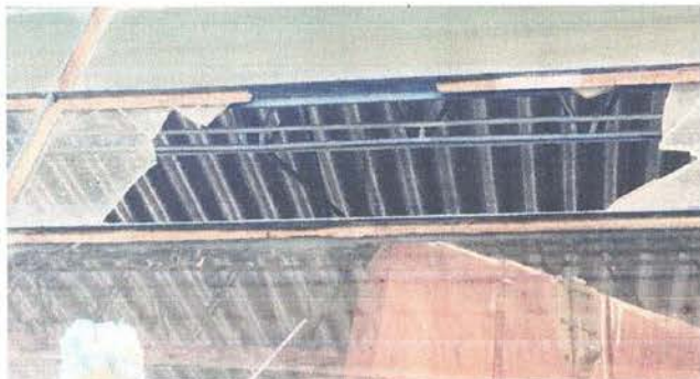
Sustitución de vidrios de ventanas (incluye estructura de soporte de metal, instalación y flete)
