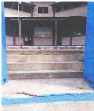
Foto 1: Reparación de 4 gradas y reparación de porton principal
