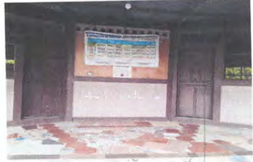
Foto 8: Reparación y pintura de puertas principales de Aulas (2 unidades) 1x2 M2; 2 M2.
