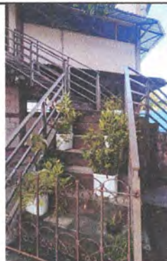
Foto 4: Lijado, cepillado y pintura de baranda de gradas que va hacia las aulas de segundo nivel 2 x5 ML, 10 ML
