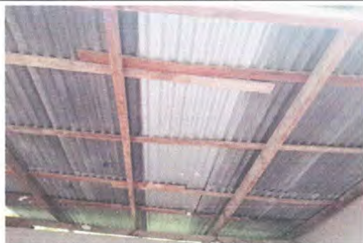
Foto 5: Desmonado de techo de pila, sustitución de lamina ondula por lamina troquelada aluzinc calibre 26 y estructura de soporte de madera por metal en techo de pila
