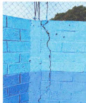
Foto 2: Mantenimiento de muro perimetral (Reforzamiento de 5 columnas de 4.00 mts lineales y vigas de 20x20 cms de grosor.)
