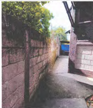
Foto 3: Lijado, cepillado y pintura de muro perimetral 100 M2
