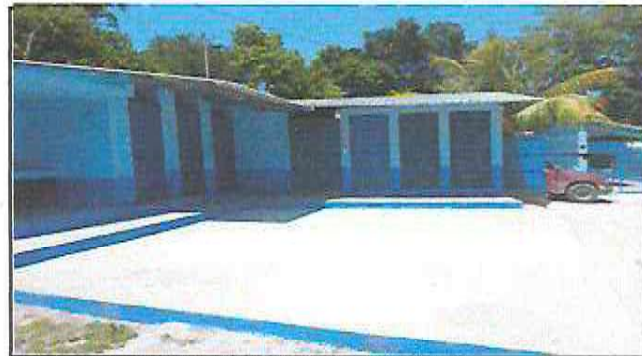
Foto 10: Reparación de planchas de concreto de patio
