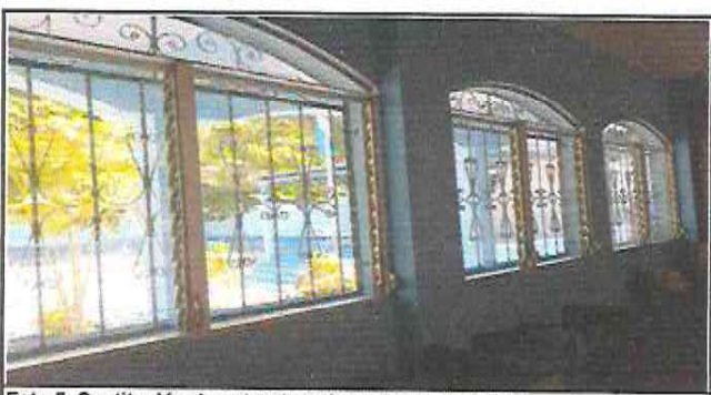
Foto 5: Sustitución de estructura de metal de ventanas
