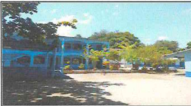
Foto 7: Pintura en muros (paredes) interiores y exteriores
