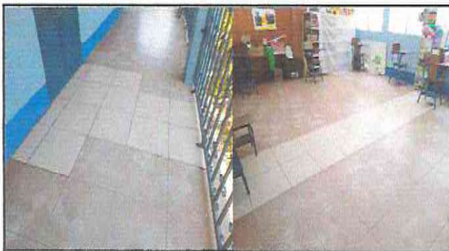
Foto 9: Suministro e instalación de piso de cerámico
