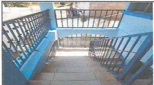
Foto 8: mantenimiento a barandas de metal (lijado, sepillado y pintura)
