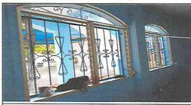
Foto 5: Sustitución de estructura de metal de ventanas
