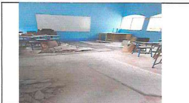
Foto 9: Suministro e instalación de piso de cerámico
