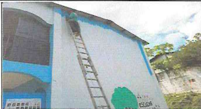
Foto 7: Pintura en muros (paredes) interiores y exteriores
