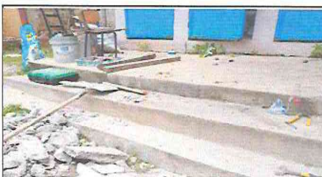
Foto 10: Reparación de planchas de concreto de patio
