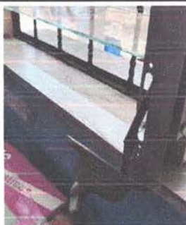
SUSTITUCION DE VENTANA
