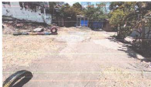
LOSA DE PATIO
