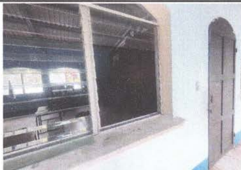
Foto 5: Sustitución de estructura de metal de ventanas
