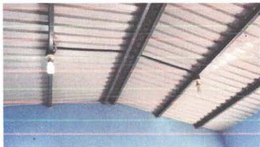
SUSTITUCION DE LAMPARAS
