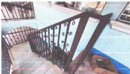
MANTENIMIENTO A BARANDAS
