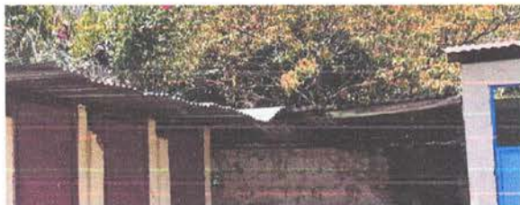
SUSTITUCION DE ESTRUCTURA Y TECHO DE LAMINA
