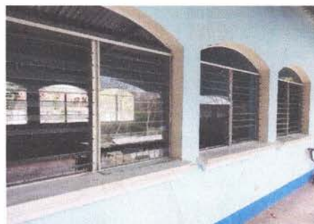
Foto 6: Sustitución de estructura de metal de ventanas y cambio de vidrios
