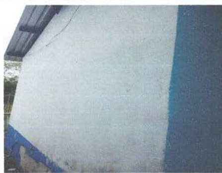
Foto 8: Pintura en muros (paredes) interiores y exteriores
