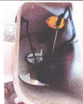
Foto 4: Sustitución de accesorios para sanitario (Contra llave, tubo de abasto y tanque)
