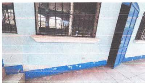
PINTURA EN MUROS
