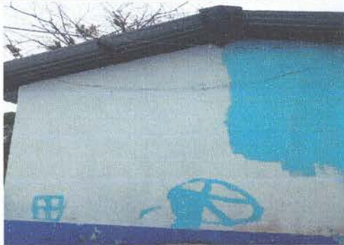
Foto 7: Pintura en muros (paredes) interiores y exteriores
