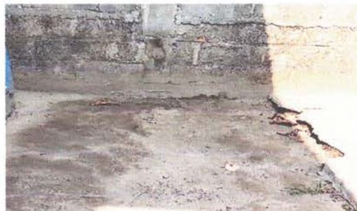
Foto 10: Reparación de planchas de concreto de patio
