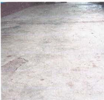
Foto 9: Suministro e instalación de piso de cerámico
