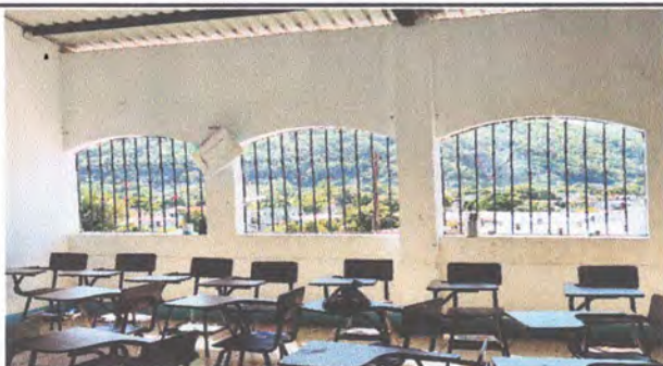
Foto 5: Instalación de ventanas de PVC en las dos aulas del segundo nivel, que no tienen ventanas y con la lluvia se moja adentro del salón de clase. Aula 1.
