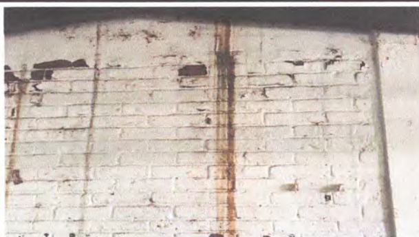
Foto 3: Daños en pared de salón de clase, por filtración de agua en el techo. Se debe repellar.
