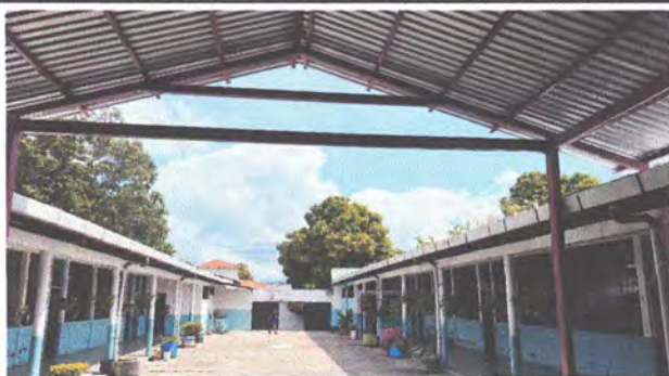
Foto1: Continuación de techo, para cubrir el los corredores y evitar que las alumnas jueguen en el sol y poder hacer nuestras reuniones con padres de familia sin que nos afecte el sol o la lluvia.
