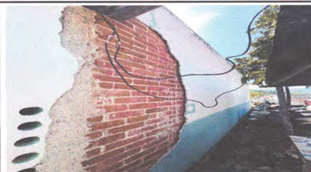
Foto 2: Se le debe aplicar sabieta en toda la pared y luego repello, para evitar que se vuelva a despegar.
