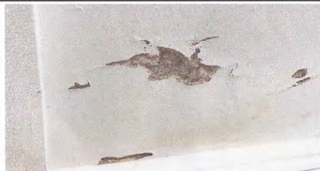
Foto 4: Daños en el techo de adentro de la dirección por el problema de filtración de agua.
