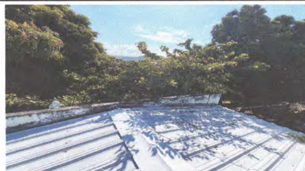
Foto 4: Se debe hacer una marquesina en el techo, para evitar que se filtre la humedad y continúe dañando la pared del aula.
