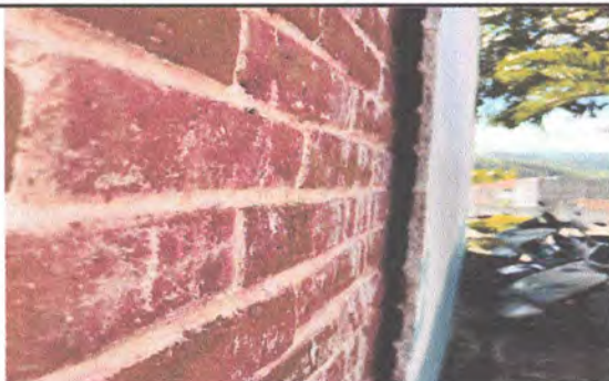
Foto1: En pares exterior de aula, se despegó todo el repello de la pared.
