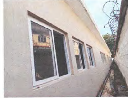
Foto 2: Ventanas adonde serán colocados los balcones. Parte de atrás.
