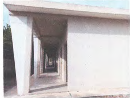
Foto 2: Pintura interior y exterior de aulas.
