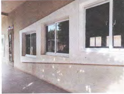
Foto 1: Ventanas adonde serán colocados los balcones. Parte frontal.
