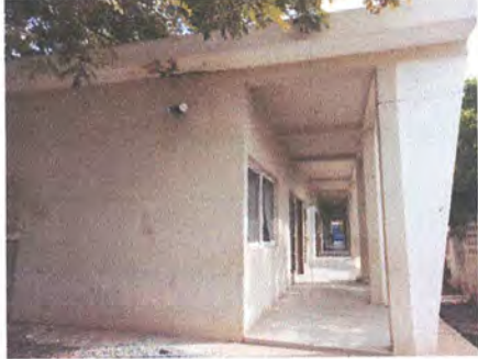
Foto1: Pintura interior y exterior de aulas.
