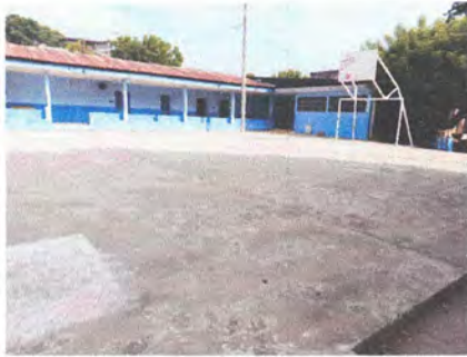
Foto 3: Pintura,marcacion de la cancha de basquetbol/papyfut.
