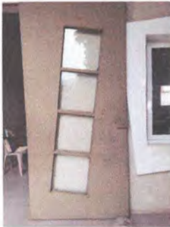
Foto 5: Puertas, lijadas, cepilladas, pintadas de metal
