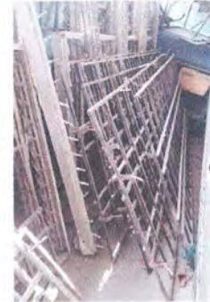
Foto 4: Reparación, adaptación e instalación de balcones.
