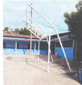
Foto 4: Pintura,marcacion de la cancha de basquetbol/papyfut.
