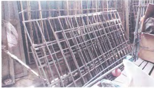
Foto 3: Reparación, adaptación e instalación de balcones.
