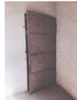
Foto 6: Puertas, lijadas, cepilladas, pintadas de metal
