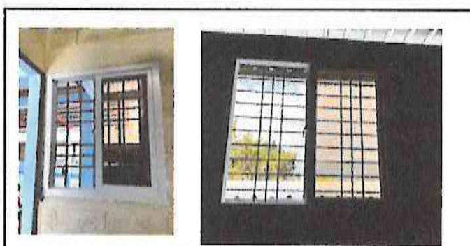
Foto 5: de balcones por ventanas corredizas de pvc.
