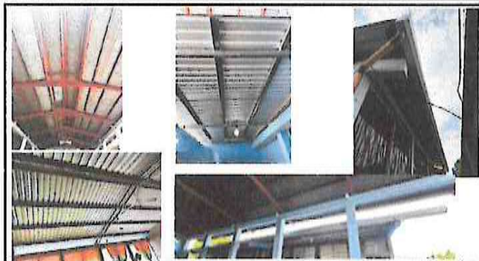
Foto1: Cambio de lámina, sustitucion de canal por canl de metal, y mantenimiento de estructura metalica.
