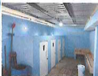
Foto 3: Repello de pared en el area de los baños. (es parte de lo que se hizo por la buena administracion de recurso)
