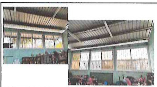
Foto 4: sustitucion de balcones de metal por Ventanas de PVC corredizas.
