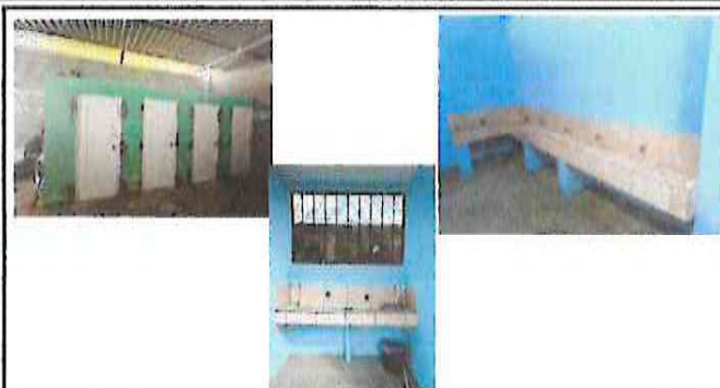
Foto 2: Sustitucion de de pla y pleta completa y chorros para lavado de manos y cambio de puertas para sanitarios.
