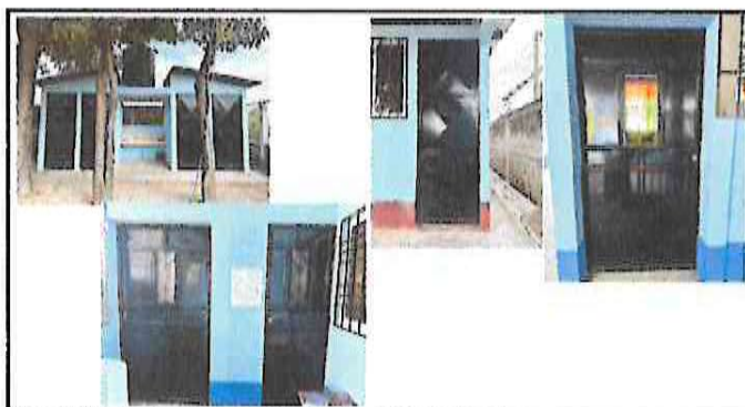
Foto 3: Mantenimiento de puerta de aulas y direccion.
