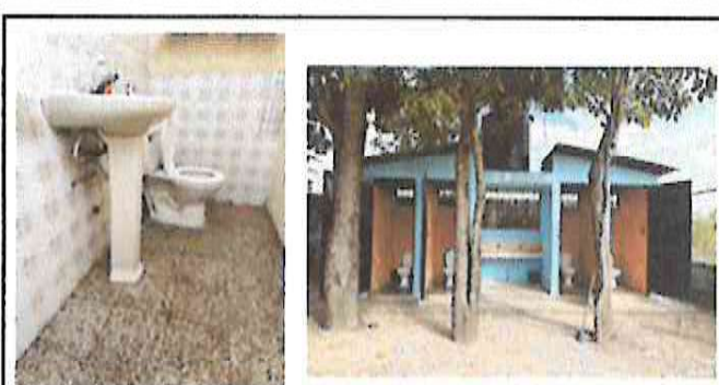
Foto 6: sustitucion lavamanos por lavmanos de buena calidad y sanitarios por sanitarios de buena calidad.
