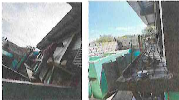
Foto 2: sustitución de canal de metal, por canal de concreto. (parte de lo que se hizo por las buena adminitracionde recursos)
