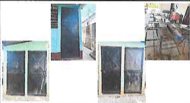
Foto 3: Mantenimiento de puerta de aulas y dirección.
