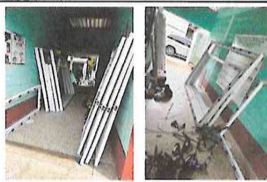
Foto 4: sustitución de balcones de metal por Ventanas de PVC coreadizas.
