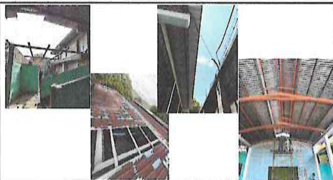
Foto1: Cambio de lámina, sustitución de canal por canal de metal, y mantenimiento de estructura metálica.
