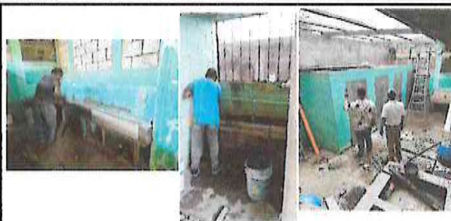
Foto 2: Sustitución de de pila y pileta completa y chorros para lavado de manos y cambio de puertas para sanitarios.
