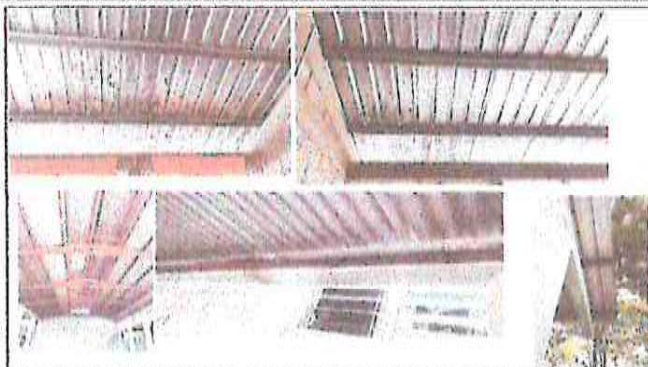
Foto 1: Cambio de lámina, sustitución de canal por canal de metal y mantenimiento de estructura metálica.
