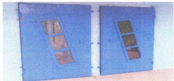
Sustitucion de chapas de las puertas de acceso
