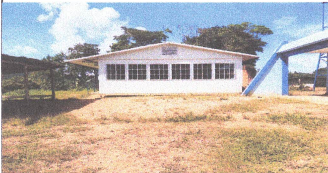
Levantamiento de estructura de metal para la galera de usos múltiples
