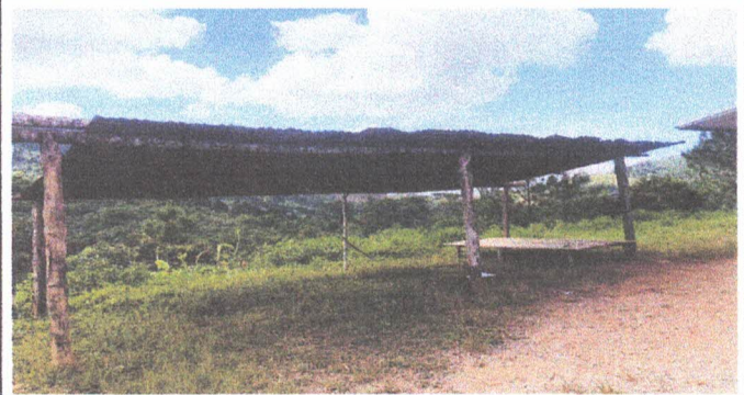
sustitucion de lamina por lamina troquelada calibre 26
