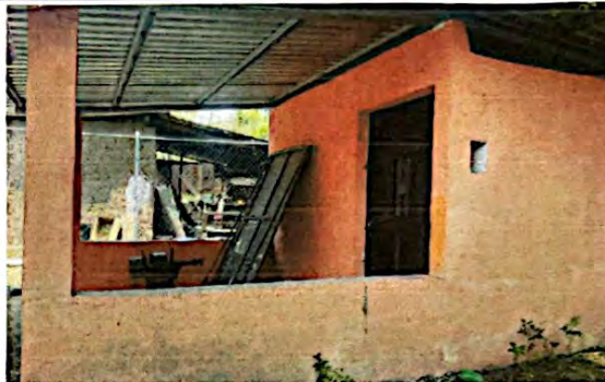
Foto 6: Pintura en muros interiores y exteriores
