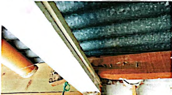
Foto 5: Sustrucción de estructura de soporte de madera por metal
