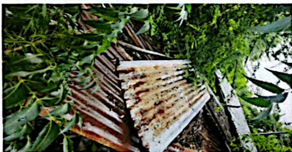
Foto 3 Modulo C Galera, necesita ser sustituida ya que el agua daño la lamina.
