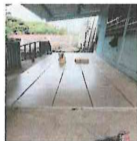
Foto 3: Piso Cerámico Instalado
