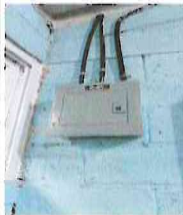
Foto 1: Sistema Eléctrico reparado
