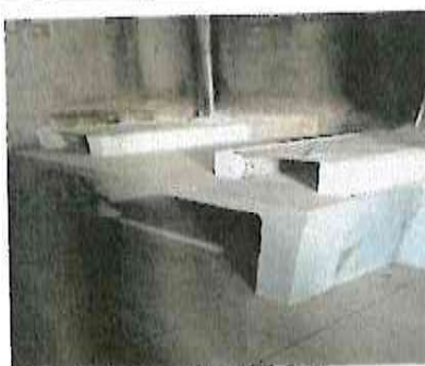
Foto 2: Instalación de planchas
