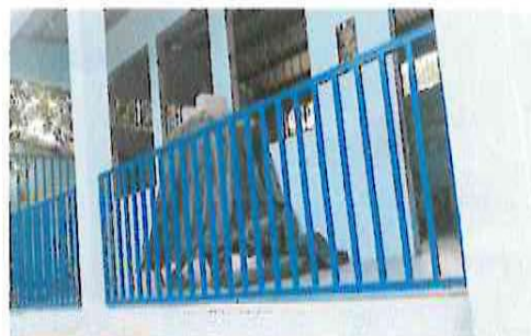
Foto 2: Instalación de barandas
