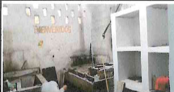
Foto 6: Reparación de cocina
