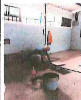
Foto 3: Instalación de piso Cerámico
