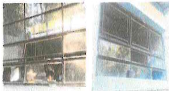
Foto 4: Reparación de Ventanas
