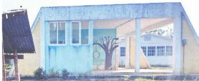
Pintura en muros (Paredes) interiores y exteriores
