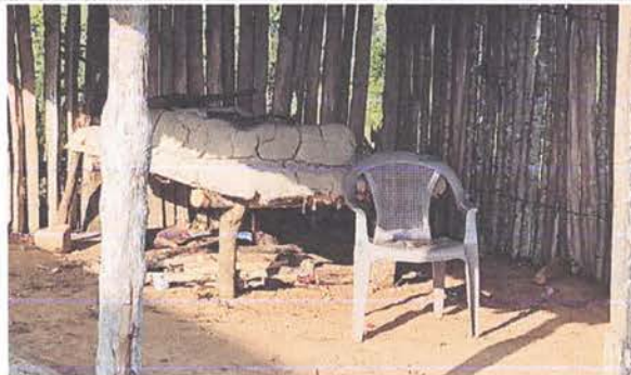
Suministro e instalación de cocina completa (Incluye polletón, plancha metálica y chimenea)
