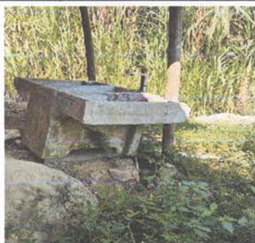
Sustitución de pila de concreto de dos lavaderos
