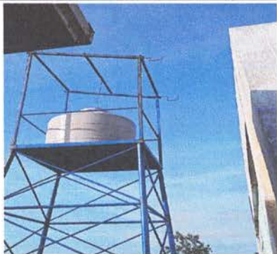
Mantenimiento a estructura de depósito de agua (Lijado, cepillado y pintado) y sustitución e instalación de cisterna de 1700 lts.
