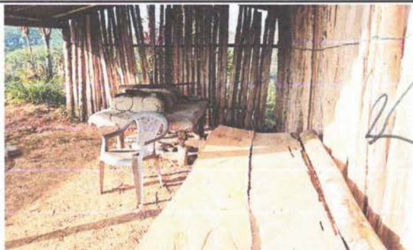
Suministro e instalación de cocina completa (incluye polletón, plancha de metal y chimenea)
