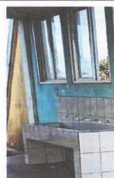
Sustitución de ventanas corredizas de tubo pvc
