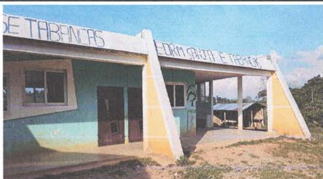
Pintura en muros (paredes) interiores y exteriores
