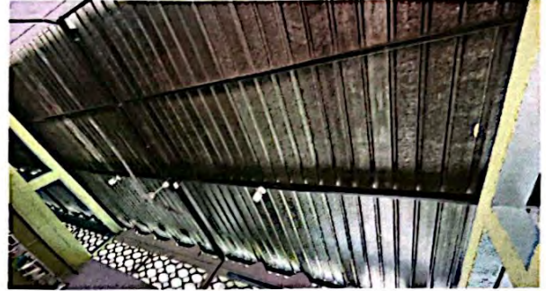
INSTALACIÓN DE CIELO FALSO
