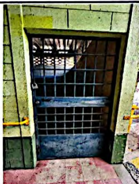
MANTENIMIENTO A ESTRUCTURA DE PUERTA
