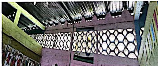
SUSTITUCIÓN DE BALCONES DE METAL
