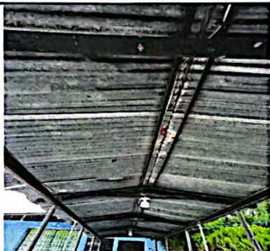
SUSTITUCIÓN DE LÁMINA POR TROQUELADA
