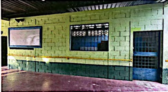
PINTURA EN MUROS INTERIORES Y EXTERIORES
