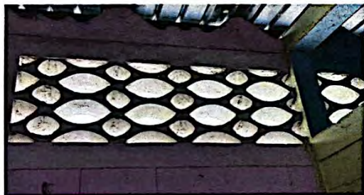
SUSTITUCIÓN DE VENTANAS DE CELOSIA POR PVC
