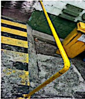
MANTENIMIENTO A TUBO DE BARANDILLA
