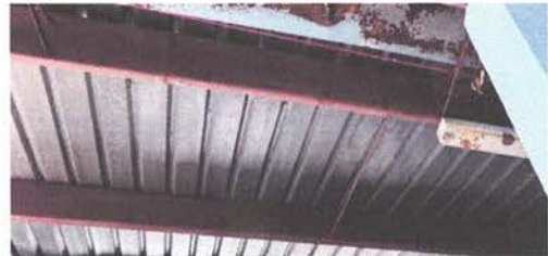
ESTRUCTURA DE TECHO
