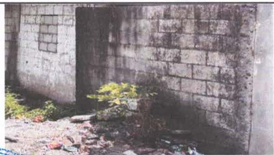
REPARACIÓN DE MURO PERIMETRAL DE BLOCK
