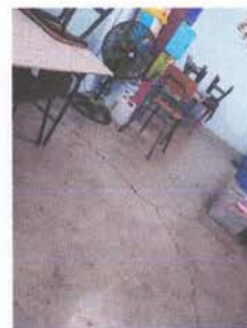
SUSTITUCION DE PISO
