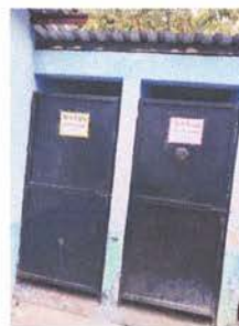
MANTENIMIENTO DE PUERTAS
