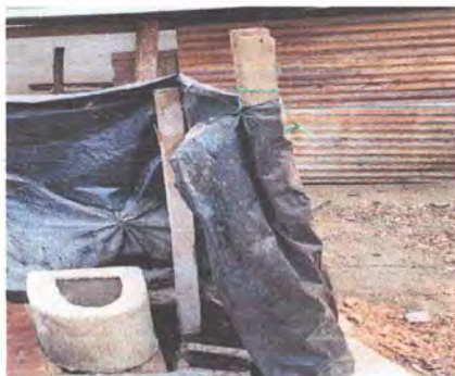
SUSTITUCIÓN DE INODORO CON SUS ACCESORIOS
