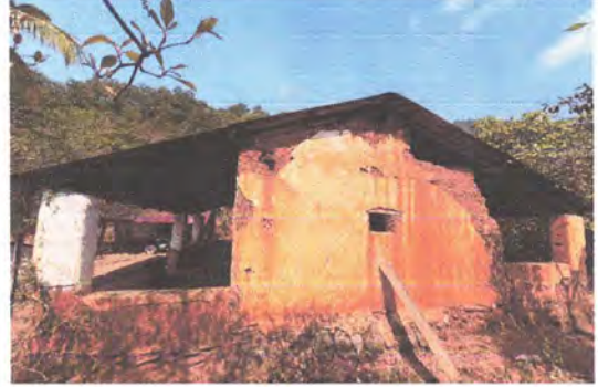
SUMINISTRO DE REPELLO EN MURO (PAREDES)
