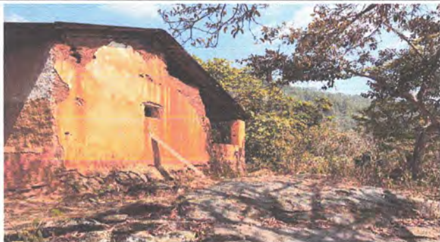
SUMINISTRO E INSTALACIÓN DE PISO DE TORTA DE CONCRETO
