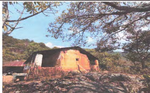
SUMINISTRO DE PINTURA INTERIOR Y EXTERIOR EN PAREDES
