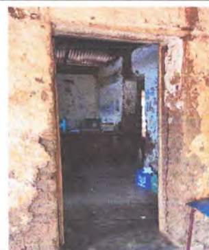
SUSTITUCIÓN DE PUERTA DE METAL
