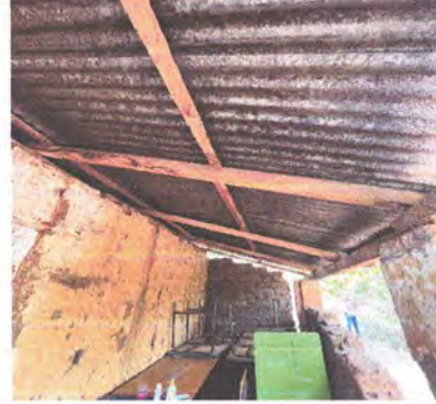
REPELLO EN MURO DE PAREDES
