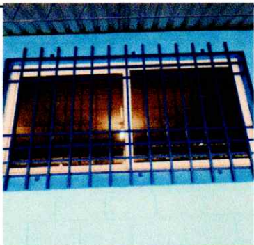
Foto 9: Balcones pintados con pintura anticorrosiva
