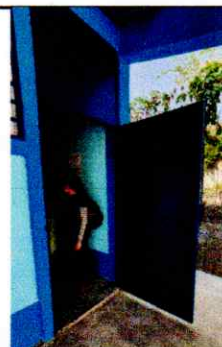
Foto 12: Puertas lijadas y pintadas con pintura anticorrosiva
