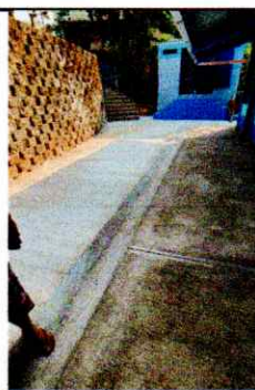
Foto 10: Mejoramiento de piso en área exterior con cuneta para conducir el agua de lluvia fuera de las aulas y evitar inundaciones
