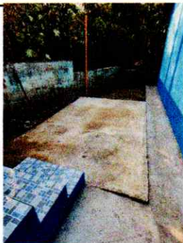
Foto 11: Fosa séptica finalizada
