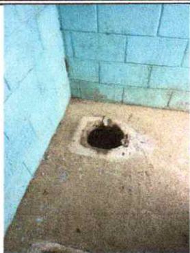
Foto 7: Remoción de letrinas antiguas, para instalar nuevos
