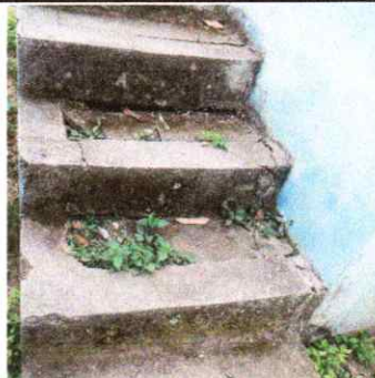
Foto 10: Prepración de gradas para fundición y por ende, mejoramiento de éstas
