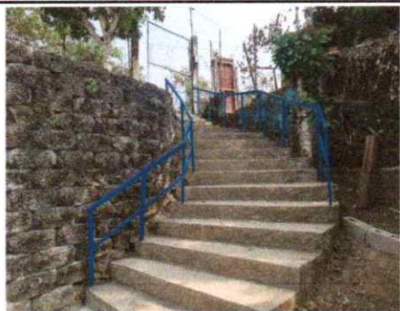
Foto 9: Remozamiento de gradas y baranda en ingreso principal
