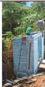
Foto 8: Instalación de lámina y costaneras nuevas en área de sanitarios
