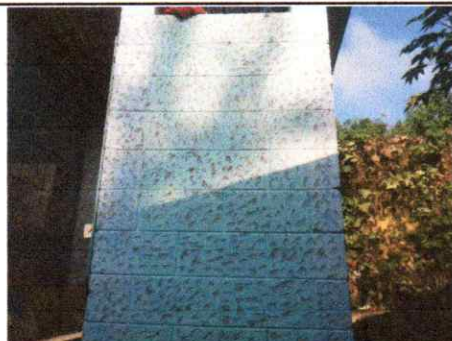
Foto 11: Preparación de paredes para la instalación de azulejo en muros exteriores de los sanitarios
