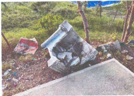
Foto 3: SUSTITUCION DE PILA
