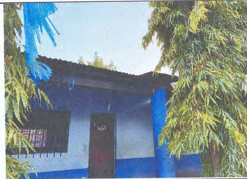
Foto 2: PINTURA EN MUROS EXTERIORES
