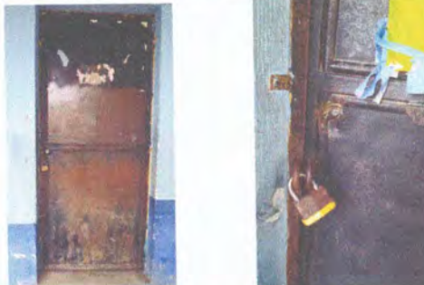
Foto 6: Renglon 7 y 8. Mantenimiento a puertas y sustitucion de chapa
