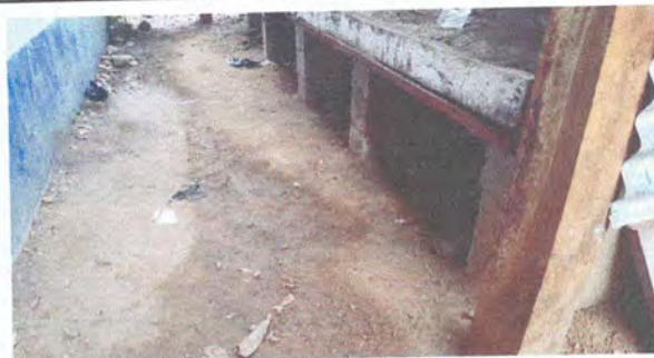
Foto 2: renglon 2. Fundicion de torta de concreto
