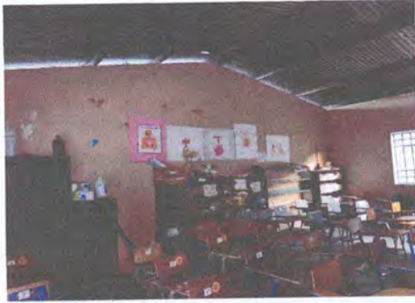
Foto1: PINTURA EN MUROS INTERIORES
