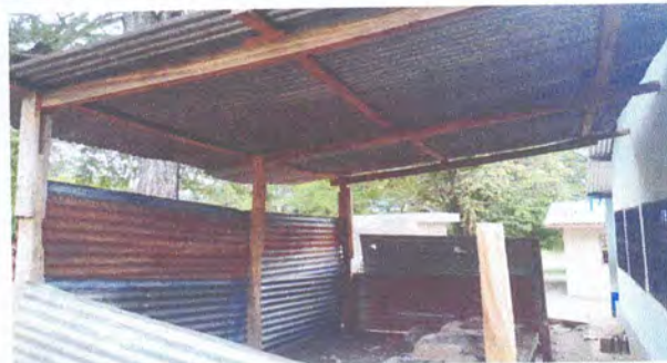
Foto 4: Renglon 4. Sustitucion de lamina por lamina troquelada
