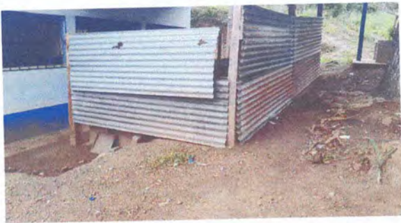
Foto 1: Renglon 1. Cambio por cerramiento con malla galvanizada
