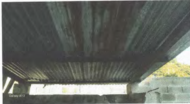
Foto 4: Sustitución de lámina por lámina troquelada calibre 26
