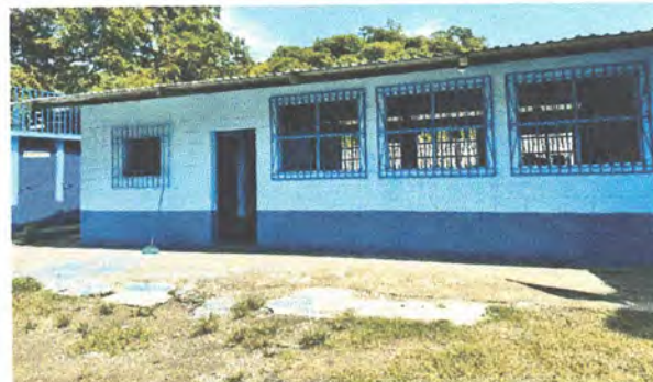
Foto 10: Sustrución de piso de torta de concreto
