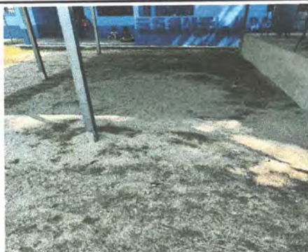
Foto 9: Sustrución de piso de torta de concreto
