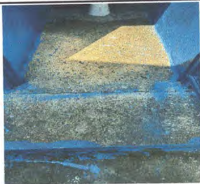
Foto 7: Sustrución de piso de torta de concreto por piso cerámico antideslizante
