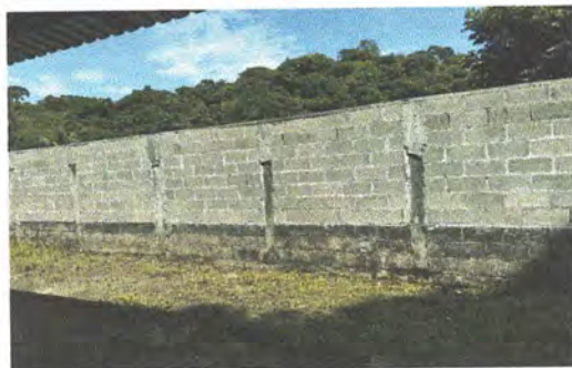
Foto 2: Repello, cernido y pintura en paredes
