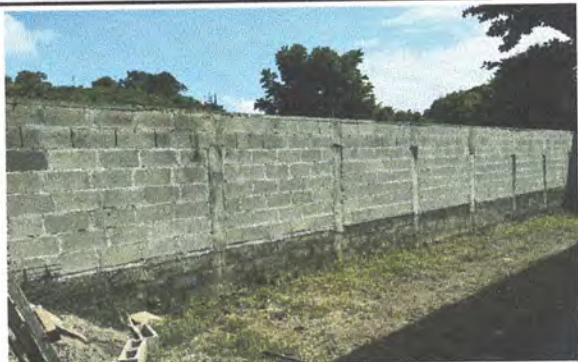
Foto 1: Repello, cernido y pintura en paredes
