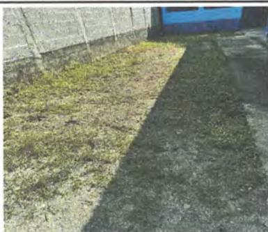
Foto 11: Sustrución de piso de torta de concreto
