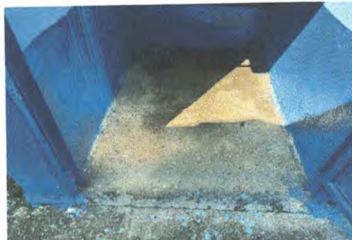
Foto 8: Sustrución de piso de torta de concreto por piso cerámico antideslizante
