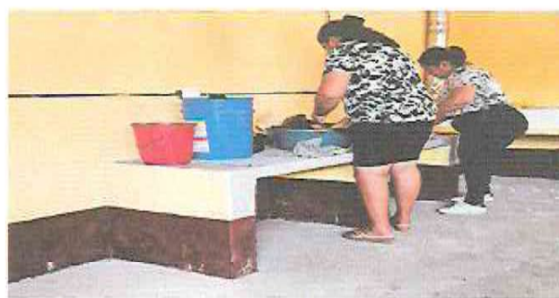
Foto 4: Elaboración de mesa de cemento para uso interno en la cocina.
