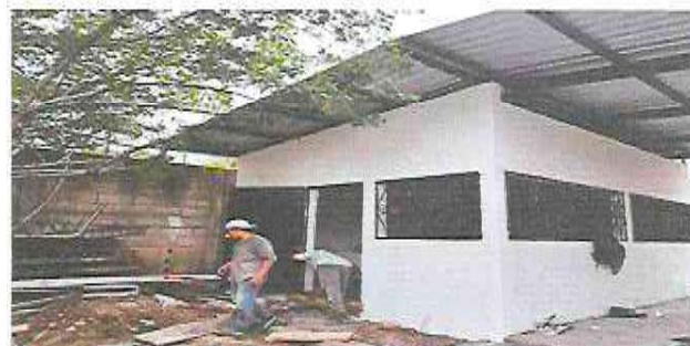
Foto 2: Elaboración de repello en paredes y torta de cemento para piso.
