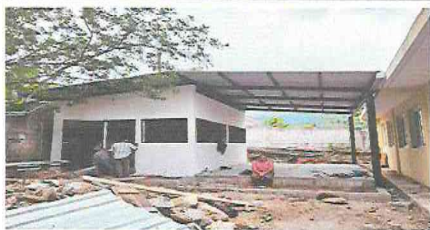
Foto 1: Colocación de lámina troquelada en la cocina.
