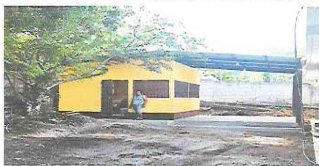
Foto 3: Pintura en muros exteriores e interiores.
