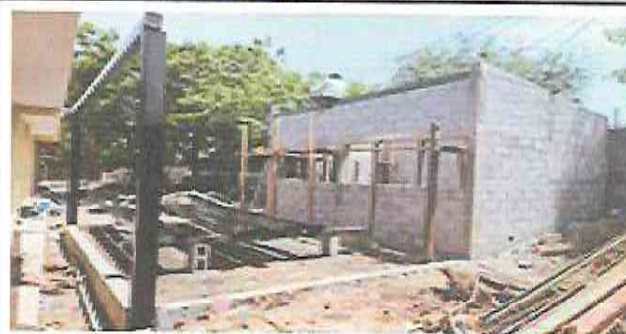
Foto 2: Estructura metálica para hacer gabra para la cocina.
