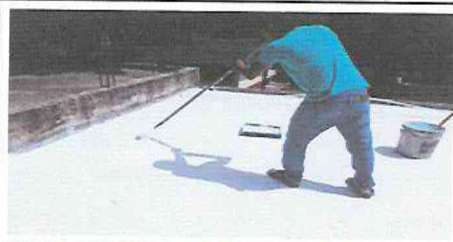
Foto 5: Primera Impermeabilización de terraza.
