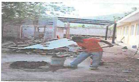
Foto1: Pegado de block en muro y laterales para completar cocina.
