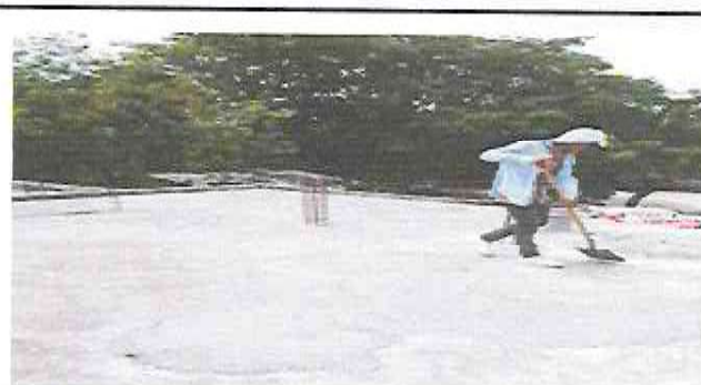
Foto 6: Segunda Impermeabilización de terraza.
