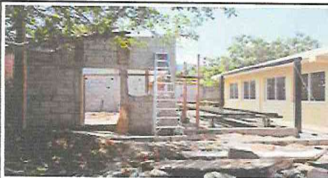
Foto 3: Estructura metálica para la cocina.
