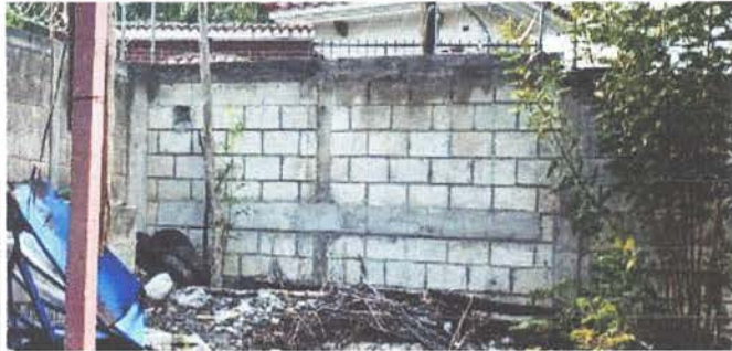
Reparación de muro perimetral
