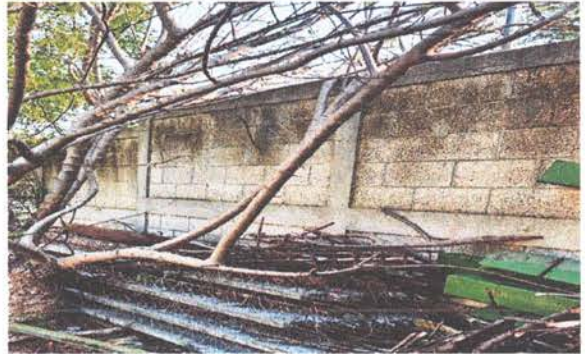
Reparación de muro perimetral
