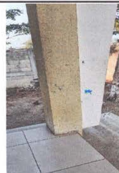
Pintura en muros exteriores e interiores
