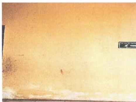
Pintura en muros exteriores e interiores
