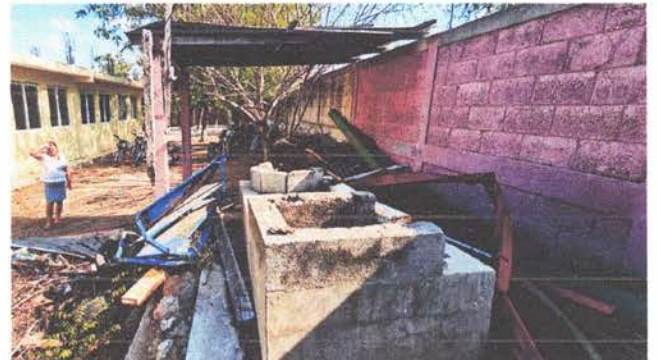
Sustitución de estufa Rural Completa (Polleto, Plancha y Chimenea)
