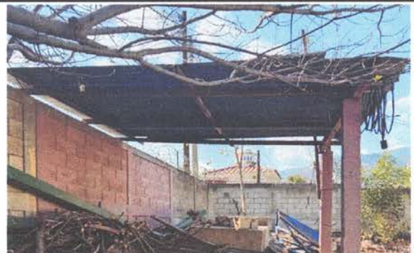
Sustitución de Lámina por Lámina troquelada Calibre 26
