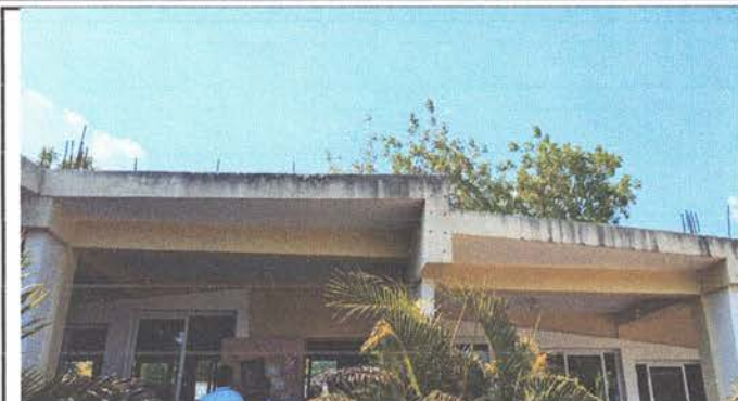
Impermeabilización de losa
