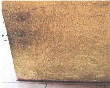
Pintura de muros interiores y exteriores
