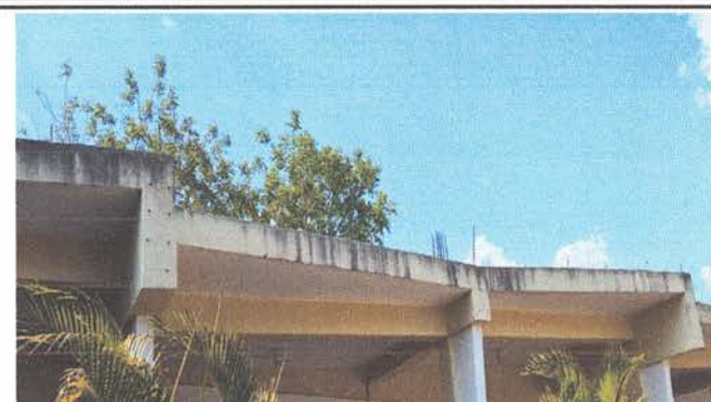
Impermeabilización de losa
