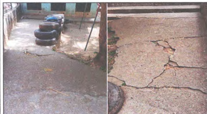
Foto 3: Reparación de rampa de acceso al patio.
