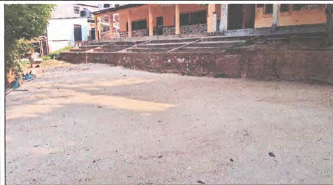
Foto 1: Mejoramiento en patio
