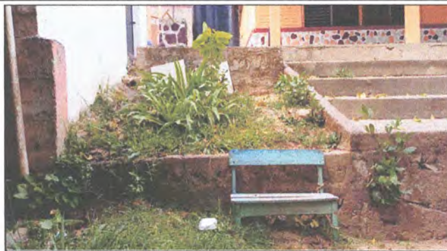
Foto 2: Mejoramiento de gradas de acceso al patio
