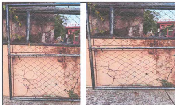
Foto 4: Instalar portón principal.
