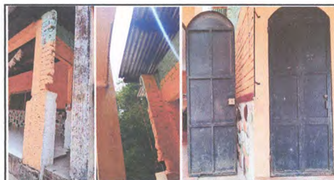
Foto 6: Mejoramiento de aulas: Reparación de columnas, cambio de lámina en techo, lijar y pintar puerta módulo 1 y 2.
