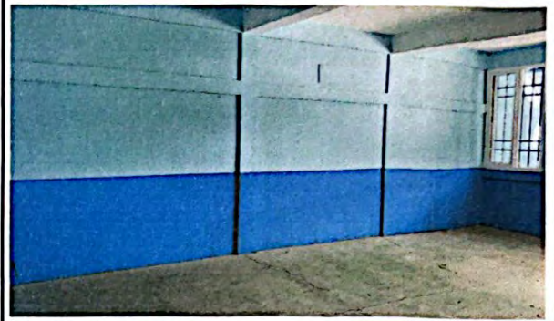
Foto 14: Instalación de estantería de concreto con entrepaños
