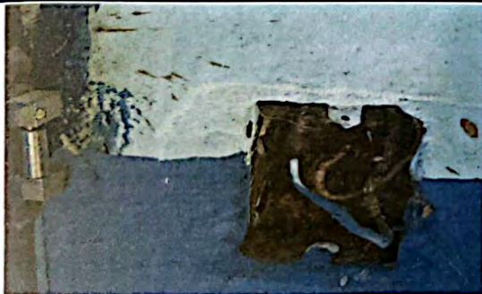
Foto 11: Instalación de unidades de fuerza (tomacorrientes)
