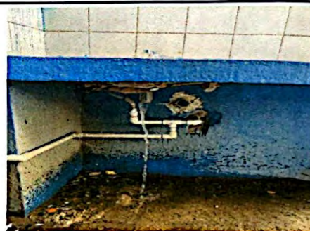
Foto 4: Reparación de tubería en lavamanos
