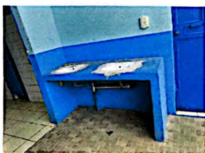
Foto 5: Sustrucción de grifos en lavamanos
