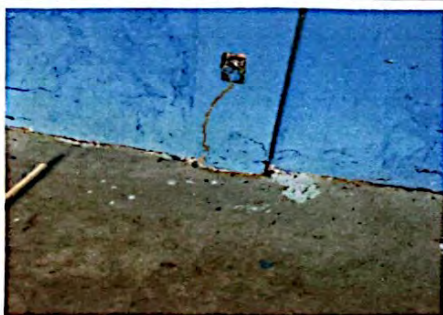
Foto 3: Reparación del sistema eléctrico
