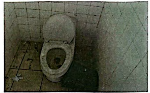
Foto 8 Sustrucción de accesorios de inodoro
