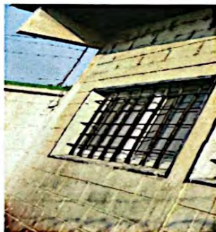
SUSTITUCIÓN E BALCONES DE METAL
