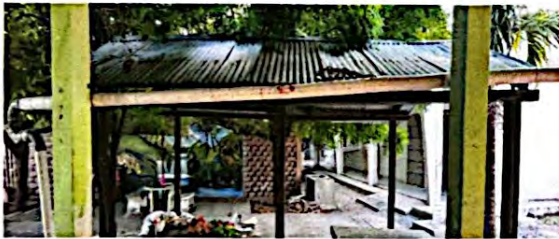
SUSTITUCIÓN DE CANAL DE PVC /
