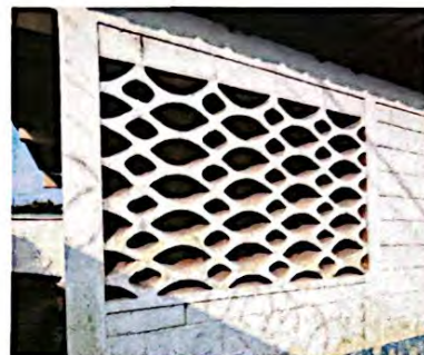
SUSTITUCIÓN DE VENTANAS DE CELOSIA POR PVC
