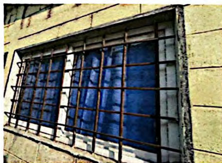
MANTENIMIENTO A BALCONES DE METAL
