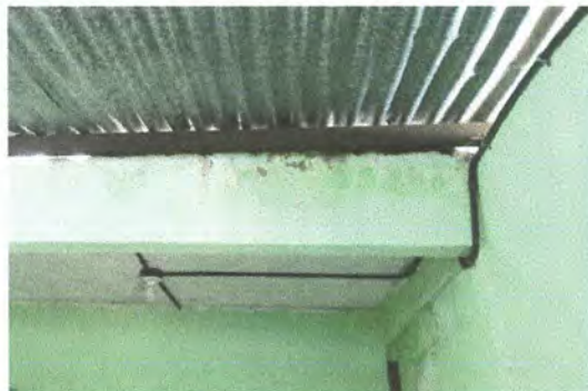
Foto 33: Sustitución de ducto eléctrico más accesorios
