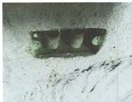
Foto 30: Sustrucción de tomacorrientes dobles
