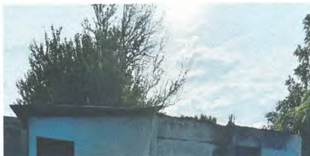
Foto 25: Sustrucción de estructura de metal
