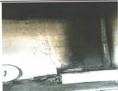
Foto1: Sustrucción de estufa rural completa (incluye polletón, plancha y chimenea)
