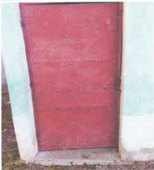
Foto 15: Mantenimiento a estructura de metal de puertas entrada de baños (Lijado, cambio de tubo, cepillado, sujeciones, aplicación de pintura)
