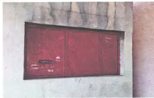
Foto 10: Mantenimiento a estructura de metal de ventana (Lijado, cambio de tubo, cepillado, sujeciones, aplicación de pintura)
