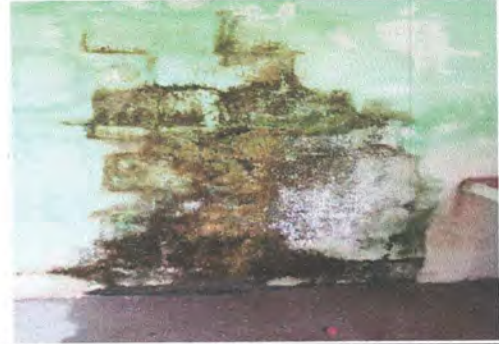
Foto 14: Repello y cernido en paredes
