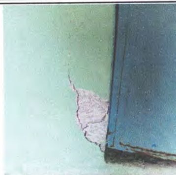
Foto 20: Repello y cernido en paredes
