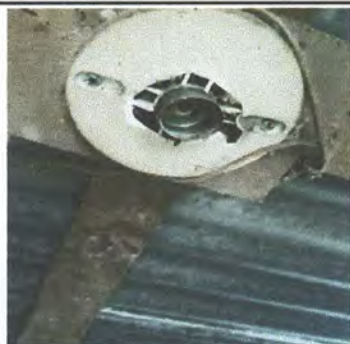
Foto 35: Sustitución de plafoneras
