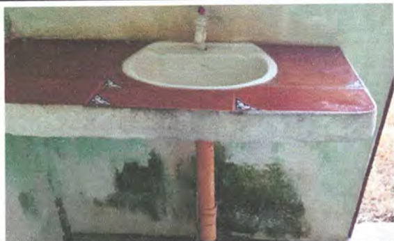
Foto 19: Sustrucción de lavamanos
