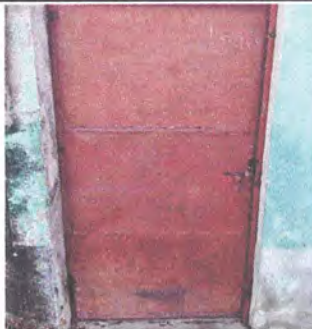
Foto 17: Mantenimiento a estructura de metal de puertas entrada de baños (Lijado, cambio de tubo, cepillado, sujeciones, aplicación de pintura)
