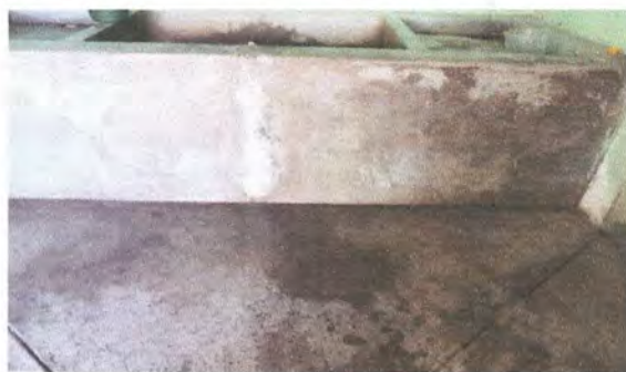
Foto 22: Sustrucción de piso de torta de concreto por piso cerámico antideslizante
