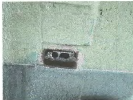
Foto 28: Sustrucción de tomacorrientes dobles
