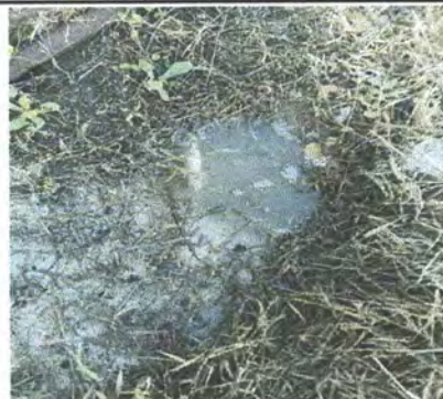
Foto 26: Sustrucción de caja de registro
