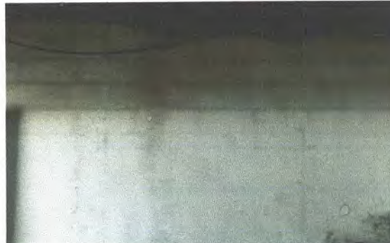
Foto 4: Pintura en muros interiores y exteriores
