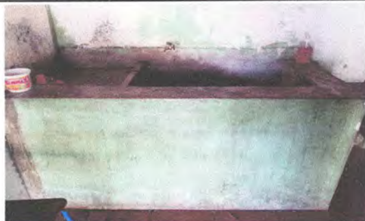
Foto 11: Sustrucción de pila de cemento dañada de un lavadero
