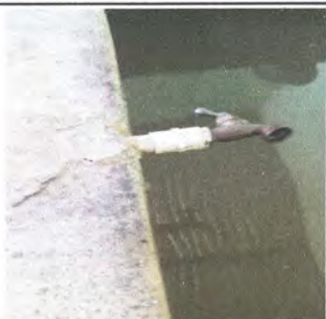
Foto 21: Sustrucción de llave de chorro
