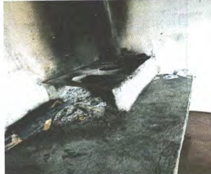
Foto2: Sustrucción de estufa rural completa (incluye polletón, plancha y chimenea)
