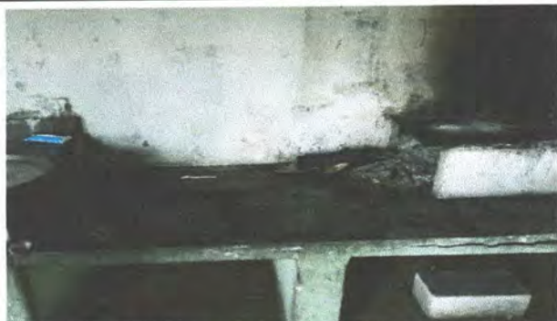
Foto 3: Sustrucción de estufa rural completa (incluye polletón, plancha y chimenea)
