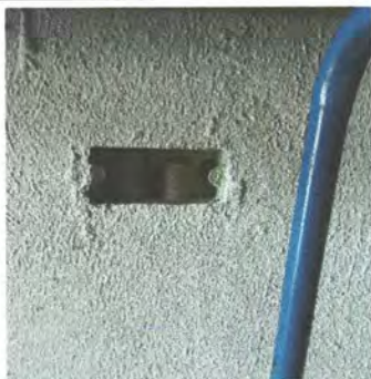
Foto 29: Sustrucción de tomacorrientes dobles
