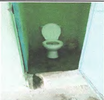
Foto 23: Sustrucción de inodoro
