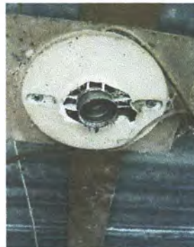
Foto 34: Sustitución de plafoneras
