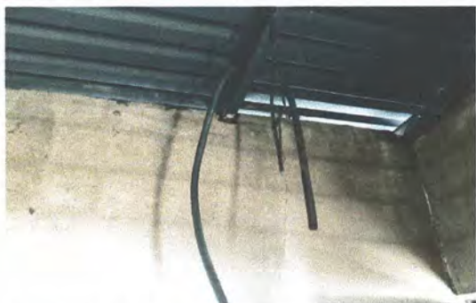
Foto 31: Sustitución de ducto eléctrico más accesorios
