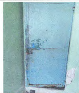
Foto 18: Mantenimiento a estructura de metal de puertas entrada de baños (Lijado, cambio de tubo, cepillado, sujeciones, aplicación de pintura)
