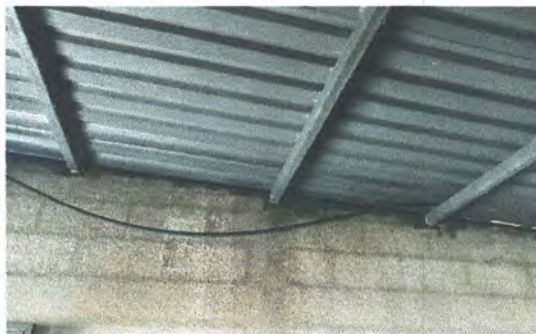
Foto 32: Sustitución de ducto eléctrico más accesorios
