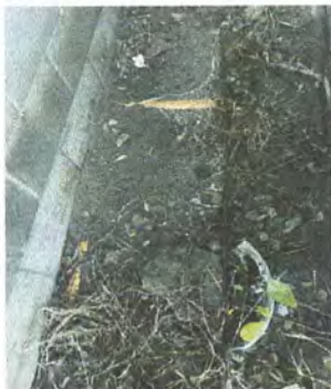
Foto 27: Reparación de banquetas de concreto
