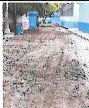
2.1 Instalación de Tubería, aguas negras línea principal
