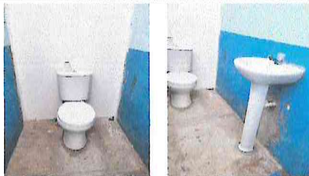
1.2 Instalación de Lavamanos y accesorios 1.4 Instalación de Sanitario con accesorios
