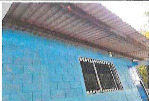
1.9 Reparación de Muro en Dirección
