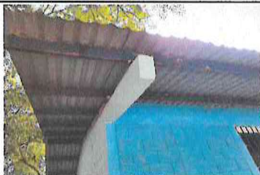
1.5 Reparación de estructura y lámina troquelada
