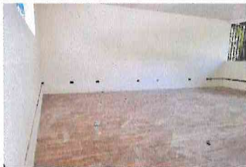
1.1 Sustitución de piso de torta de concreto
