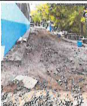
2.1 Instalación de Tubería, aguas negras línea principal
