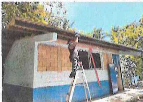
1.9 Reparación de Muro en Dirección
