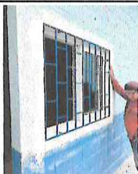
1.8 Mantenimiento de Balcones de Metal
