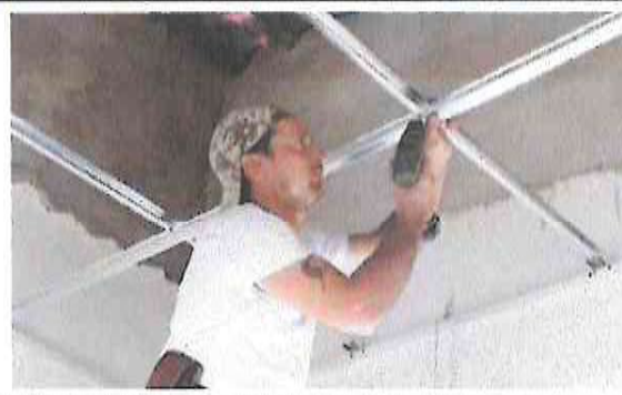
1.6 Sustitución de Estructura de Metal, por cielo falso
