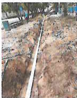
2.1 Instalación de Tubería, aguas negras línea principal
