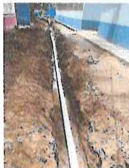
2.1 Instalación de Tubería, aguas negras línea principal
