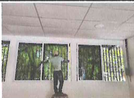
1.7 Sustitución de Ventana de metal, por ventana PVC
