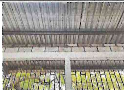
1.9 Reparación de Muro en Dirección
