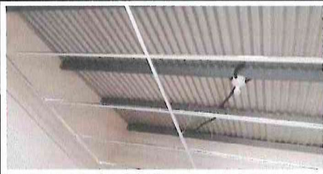
1.6 Sustitución de Estructura de Metal, por cielo falso
