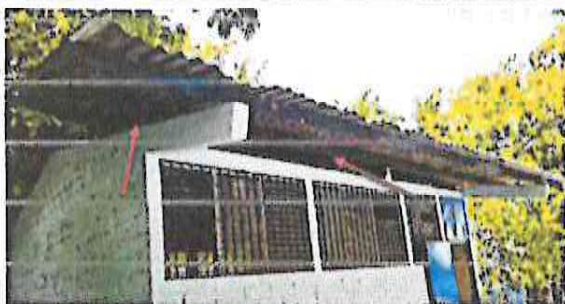
1.0 Reparación de Muro en Dirección
