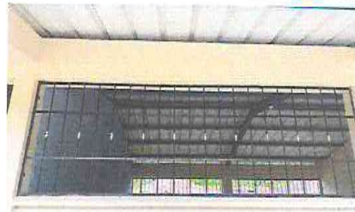
Foto 2: Mantenimiento a estructura de metal
