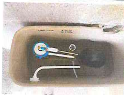
Foto 14: Reposición de accesorios de sanitarios
