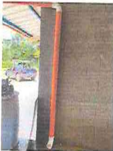
Foto 3: Sustitución de canal y bajada de agua pluvial
