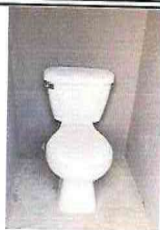
Foto 7: Sustitución de sanitarios
