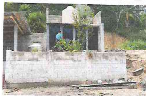
Foto 12: Refuerzo de base de baños
