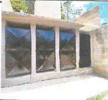
Foto 1: Sustitución de puertas en sanitarios
