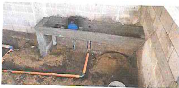
Foto 13: Sustitución de líneas de drenaje
