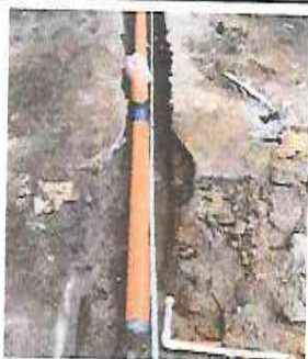
Foto 9: Sustitución de tubería de agua
