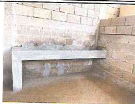
Foto 8: Sustitución de lavamanos
