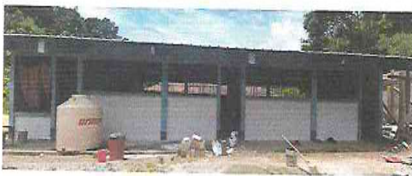
Foto 5: Mejoramiento a pared de frente
