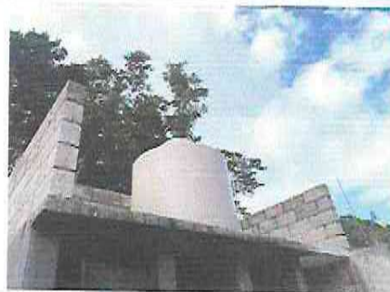
Foto 6: Cambio de depósito de agua
