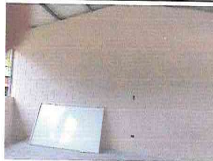
Foto 4: Aplicación de pintura a interiores y exteriores
