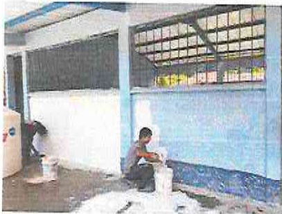
Foto 5: Mejoramiento de pared de frente
