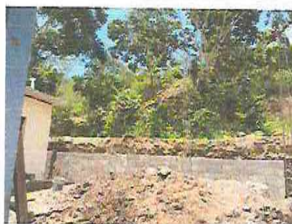
Foto 10: Reparacion de muro de contencion para resguardo de cocina
