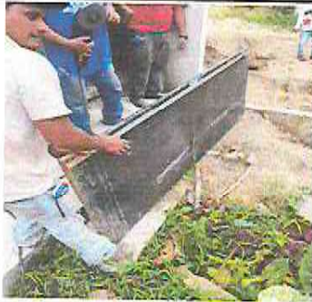
Foto1: Sustitución de puertas en sanitarios
