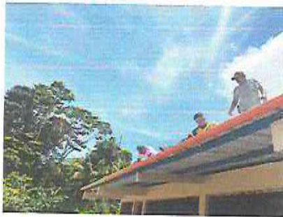
Foto 3: Sustitución de canal y bajada de agua pluvial
