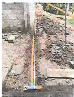
Foto 9: Sustitucion de tubería de agua
