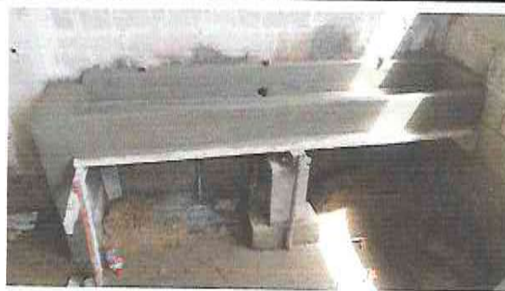
Foto 8: Sustitucion de lavamanos
