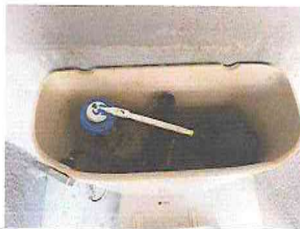
Foto 14: Reposición de accesorios de sanitarios
