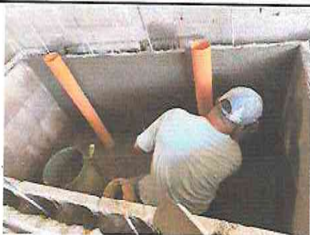
Foto 11: Sustitucion de pila de cemento de dos lavaderos
