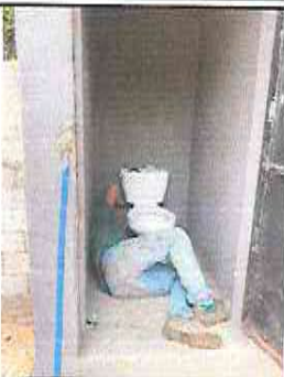
Foto 7: Sustitucion dde sanitarios
