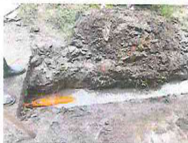
Foto13: Sustitución de líneas de drenaje
