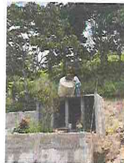
Foto 6: Cambio de deposito de agua
