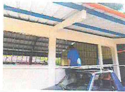
Foto 2: Mantenimiento a estructura de metal
