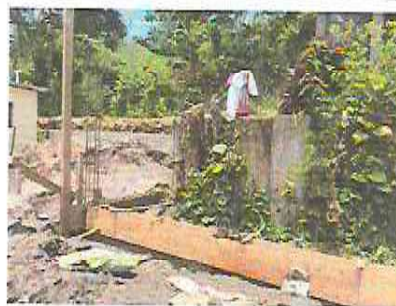
Foto 12: Refuerzo de base de baños, renglon cambiado
