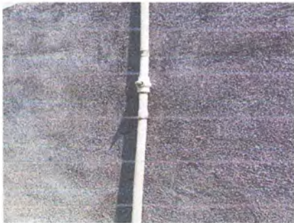
Foto 9: Sustitución de tubería de agua
