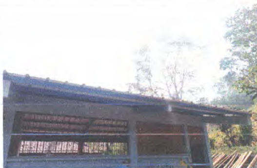
Foto 3: Mantenimiento a estructuras de metal de ventanas
