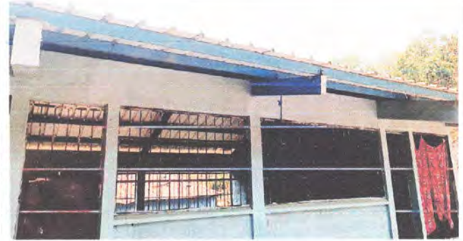
Foto 14: Mantenimiento a estructura de soporte de metal
