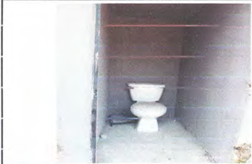
Foto 7: Sustitución de Sanitarios
