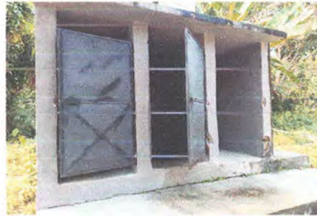
Foto 8: Sustitución de Lavamanos
