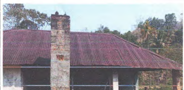
Foto 12: Sustitución de estructura de lámina por lámina troquelada calibre 26
