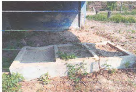
Foto 11: Sustitución de Pila de Cemento de un lavadero
