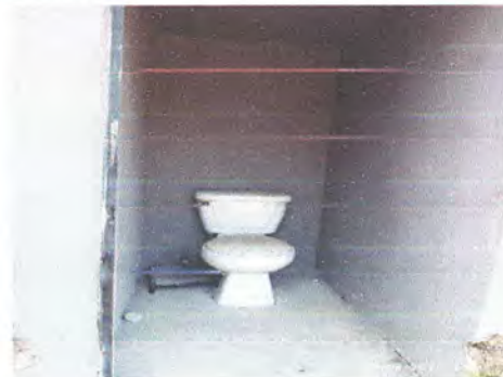
Foto 2: Sustitución de puertas en servicio sanitario
