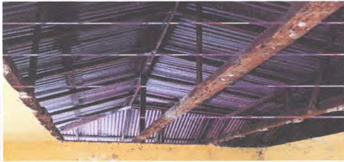
Foto 13: Sustitución de estructura de soporte de metal
