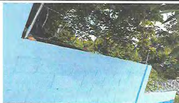
Foto 20: Después instalación de alambre razor de seguridad tipo circular
