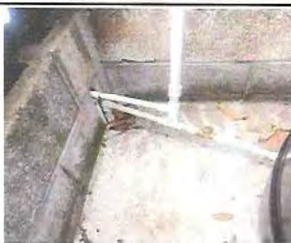
Foto 33: Después reparación de tubería de depósito de agua
