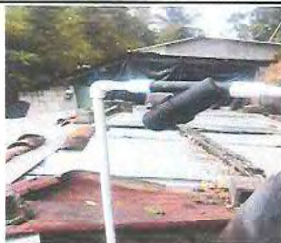
Foto 31: Después reparación de tubería de depósito de agua
