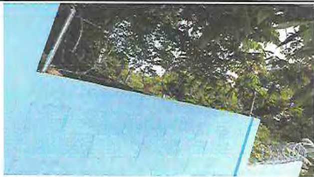
Foto 7: Después pintura en muros de interior y exterior
