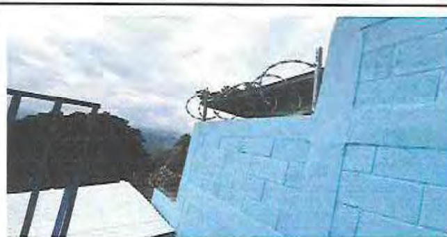
Foto 22: Después instalación de alambre razor de seguridad tipo circular
