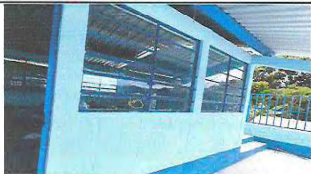
Foto 13: Después mantenimiento de balcones de metal (incluye lijado cepillado y pintura)
