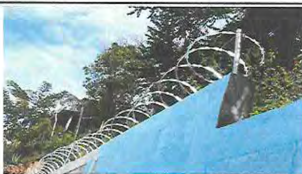
Foto 17: Después instalación de alambre razor de seguridad tipo circular
