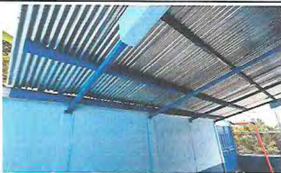
Foto 9: Después pintura en muros de interior y exterior
