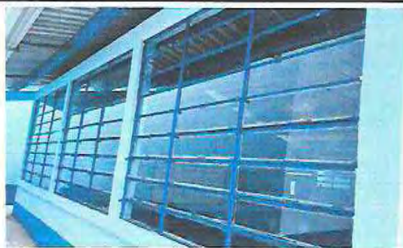
Foto 15: Después mantenimiento de balcones de metal (incluye lijado cepillado y pintura)
