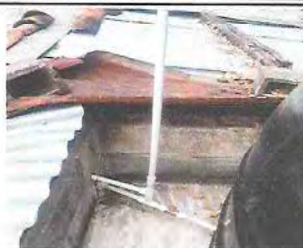
Foto 32: Después reparación de tubería de depósito de agua
