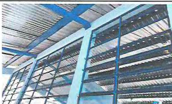
Foto 16: Después mantenimiento de balcones de metal (incluye lijado cepillado y pintura)
