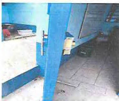
Foto 11: Después sustitución de chapas de puertas de módulo aulas
