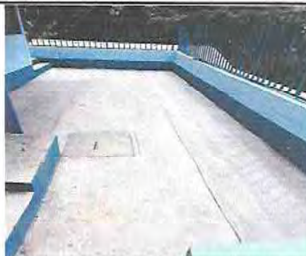
Foto 8: Después pintura en muros de interior y exterior
