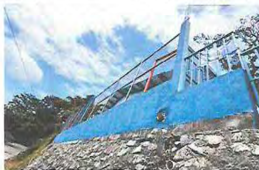
Foto 10: Después pintura en muros de interior y exterior
