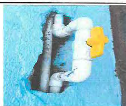
Foto 34: Después reparación de tubería de depósito de agua
