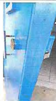
Foto 12: Después sustitución de chapas de puertas de módulo aulas
