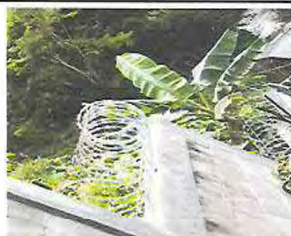
Foto 18: Después instalación de alambre razor de seguridad tipo circular
