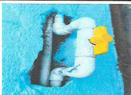
Foto 35: Después reparación de tubería de depósito de agua
