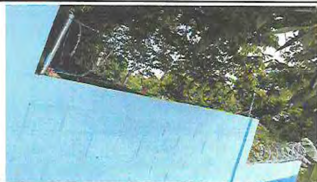
Foto 21: Después instalación de alambre razor de seguridad tipo circular
