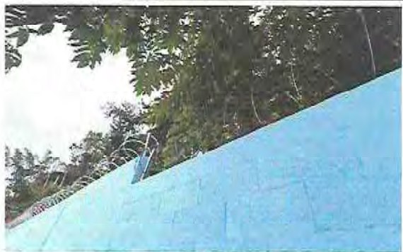
Foto 19: Después instalación de alambre razor de seguridad tipo circular
