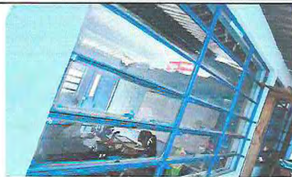
Foto 14: Después mantenimiento de balcones de metal (incluye lijado cepillado y pintura)
