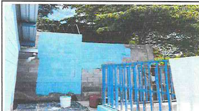
Foto 4: Durante pintura de muros interior y exterior
