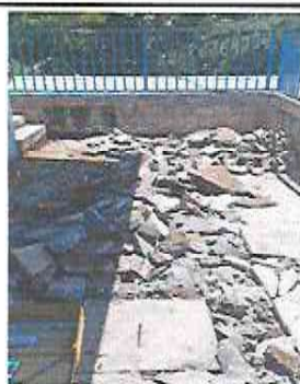
Foto 11: Durante reparación de torta de concreto
