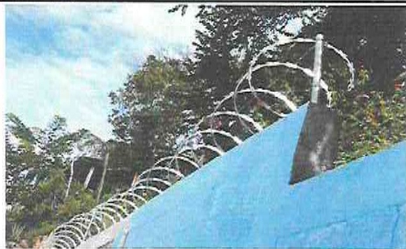
Foto 1: Durante pintura en muros interior y exterior
