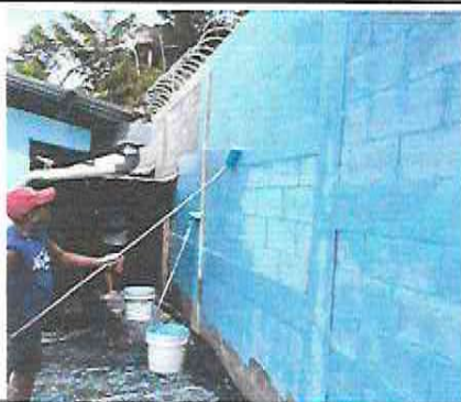
Foto 3: Durante pintura de muros interior y exterior
