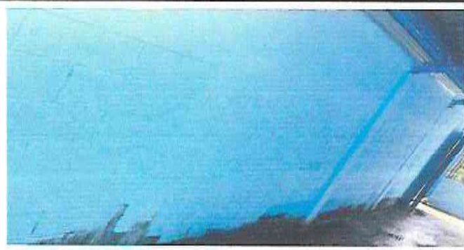
Foto 7: Durante pinturas de muro en interior y exterior
