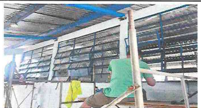
Foto 9: Durante mantenimiento de balcones de metal ( incluye lijado cepillado y pintura )
