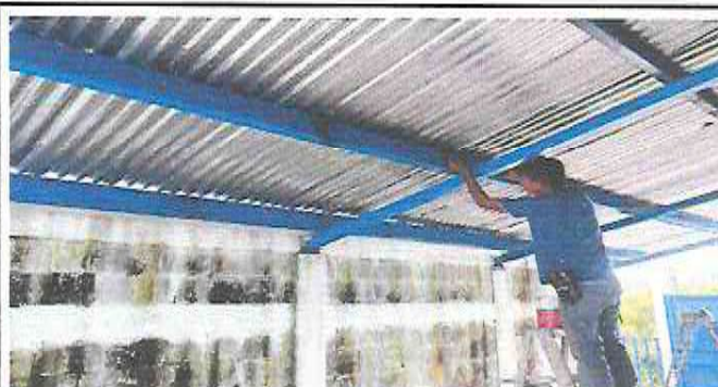
Foto 10: Durante sustitución e instalación de lámina troquelada calibre 26
