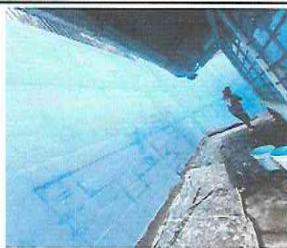
Foto 2: Durante pinturas en muros de interior y exterior
