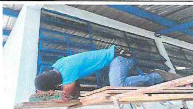
Foto 8: Durante mantenimiento de balcones de metal ( incluye lijado cepillado y pintura )
