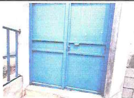
Foto 38: Sustitución del portón de ingreso
