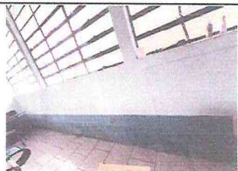
Foto 18: Mantenimiento Balcones de metal
