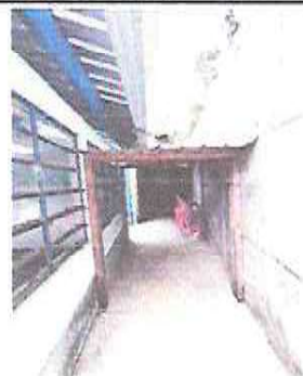
Foto 32: Sustrución de estructura de soporte de metal por metal
