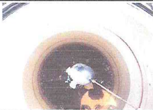
Foto 37: Sustitución de accesorios depósitos de agua
