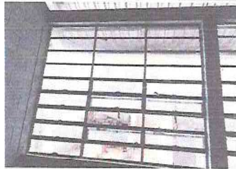
Foto 16: Mantenimiento Balcones de metal
