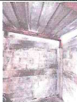
Foto 34: Sustrución de estructura de soporte de metal por metal
