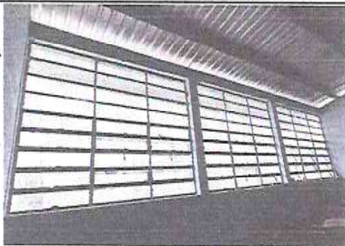
Foto 17: Mantenimiento Balcones de metal
