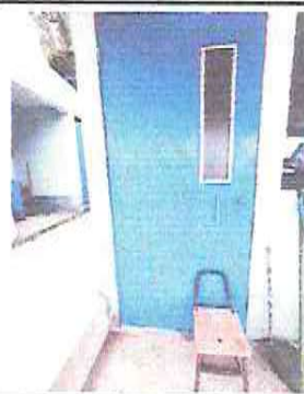
Foto 14: Sustrucción de chapas en puertas de modulos
