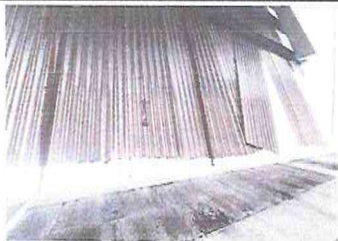
Foto 31: Sustrución de estructura de soporte de metal por metal y sustitución de lamina troquelada
