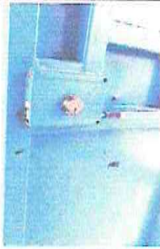
Foto 13: Sustrucción de chapas en puertas de modulo
