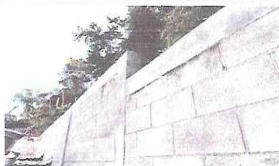
Foto 40: instalacion de malla y tubería HG de muro perimetral
