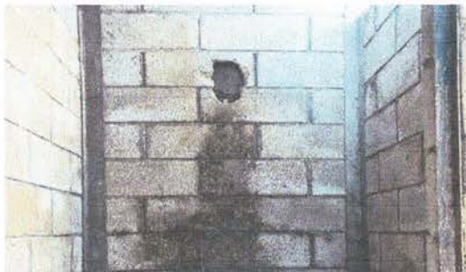
Foto 1: azulejos en muros de sanitarios
