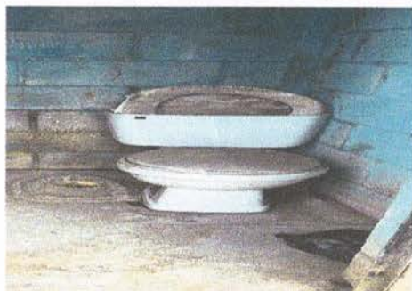
Foto 1: sustitución de inodoros
