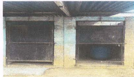
Foto 4: sustitucion de puertas en servicios sanitarios
