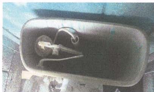
Foto 2: sustitución de accesorios inodoro (contra llave, tubo de abasto)
