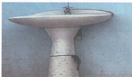
Foto 3: sustitución de lavamanos
