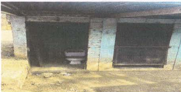
Foto 5: sustitucion de puertas en servicios sanitarios
