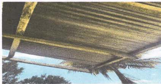
Foto 3: sustitucion de estructura de madera, por metal
