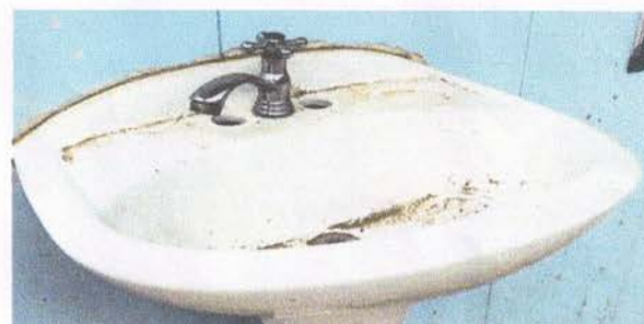
Foto 4: sustitución de mezcladora lavamanos (contra llave, tubo de abasto)
