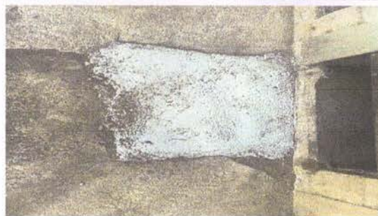
Foto 5: sustitución de fosa séptica
