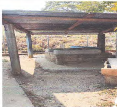
SUSTITUCIÓN DE LAMINA POR LAMINA TROQUELADA CALIBRE 26 Y SOPORTE DE ESTRUCTURA METALICA (COSTANERA)
