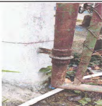
MANTENIMIENTO A ESTRUCTURA DE METAL PORTON
