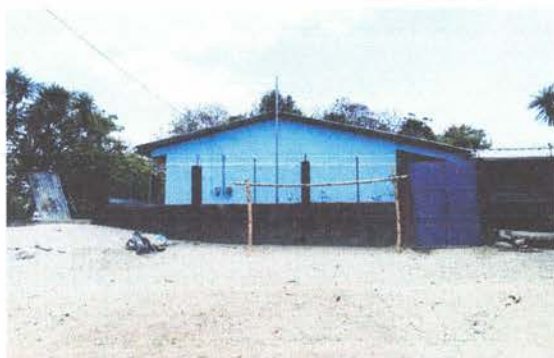
PINTURA EN MUROS EXTERIORES E INTERIORES
