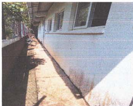
PINTURA EN MUROS INTERIORES Y EXTERIORES
