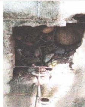
SUSTITUCIÓN DE MURO PERIMETRAL DE BLOCK INCLUYE LA FABRICACIÓN DEL MURO DE CONTENSIÓN POR EL AREA VULNERABLE QUE SE ENCUENTRA LA ESCUELA
