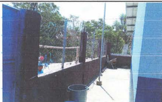
PINTURA EN MUROS INTERIORES Y EXTERIORES
