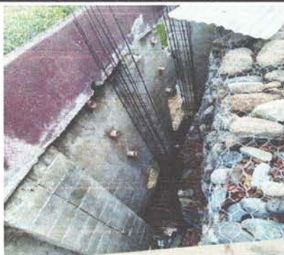
SUSTITUCIÓN DE MURO PERIMETRAL DE BLOCK INCLUYE LA FABRICACIÓN DEL MURO DE CONTENSIÓN POR EL AREA VULNERABLE QUE SE ENCUENTRA LA ESCUELA
