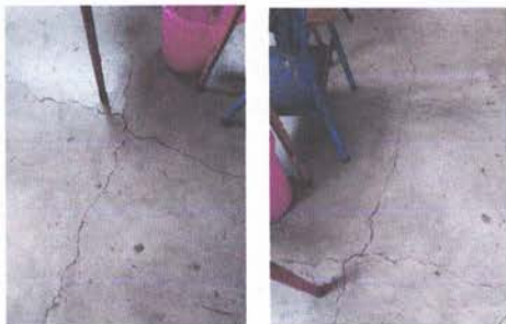
Sustitución de Piso
