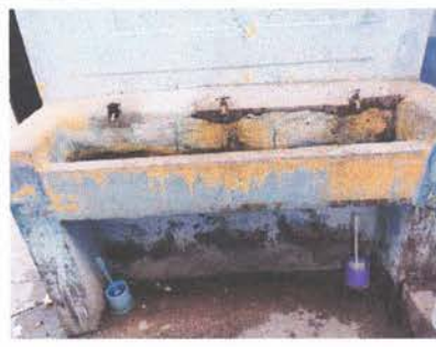
CAMBIO DE GRIFOS Y MANTENIMIENTO DE LAVAMANOS
