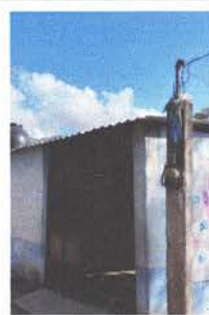
MANTENIMIENTO A PORTON
