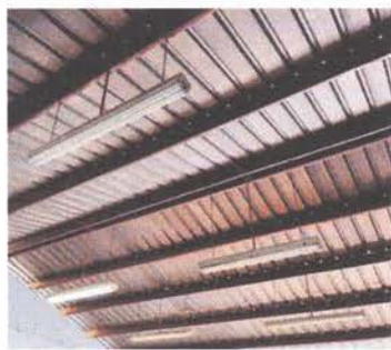
REPARACIÓN DE SISTEMA ELECTRICO
