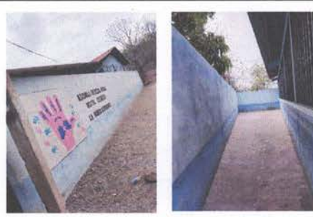
PINTURA EN MUROS EXTERIORES E INTERIORES
